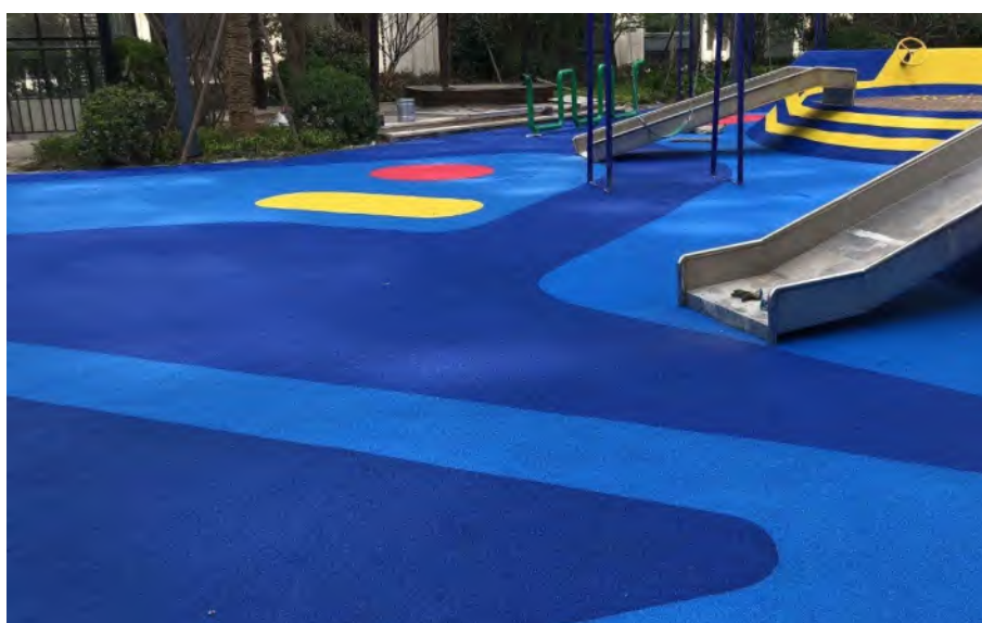
图 4-6 彩色透水塑胶铺装示意图
