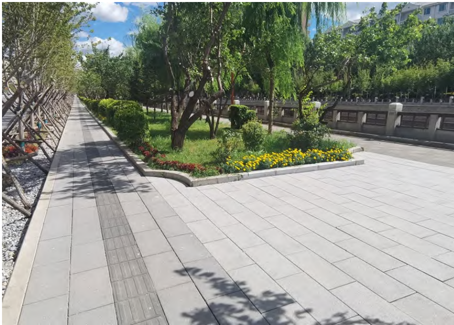
图 4-3 仿石材縫隙型透水砖铺装示意图
