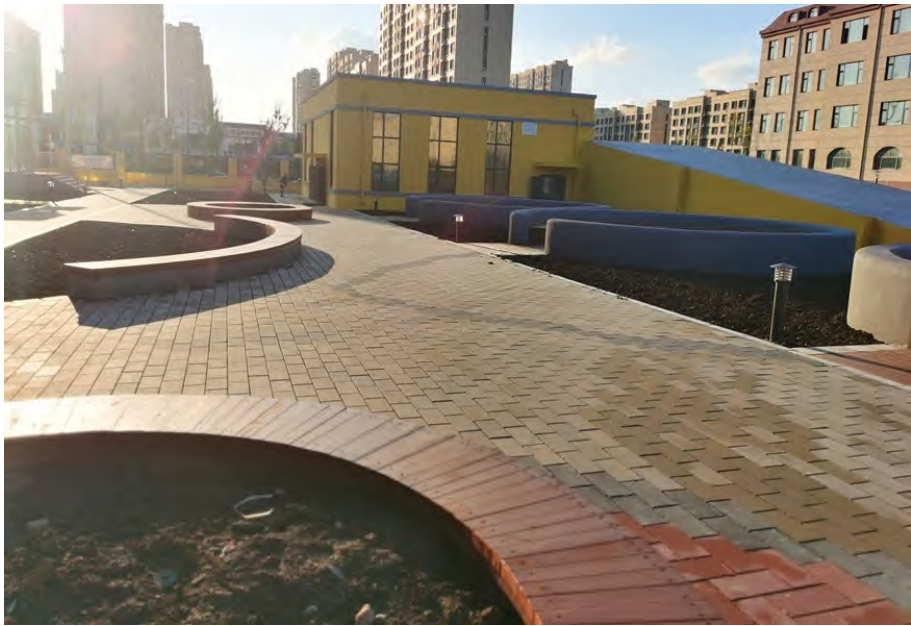
图 4-2 缝隙型透水砖铺装示意图
