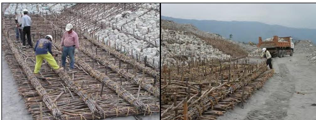
圖 19 打樁圖 20 編柵
