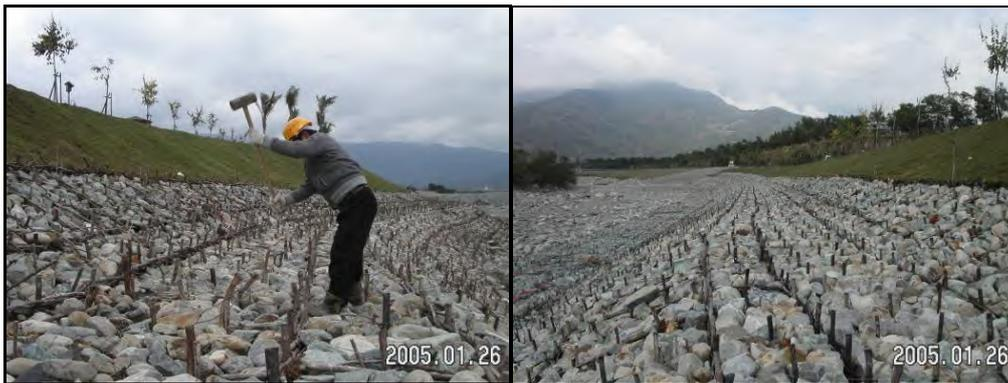
圖九打設活木樁圖十柳枝工完成後全景
