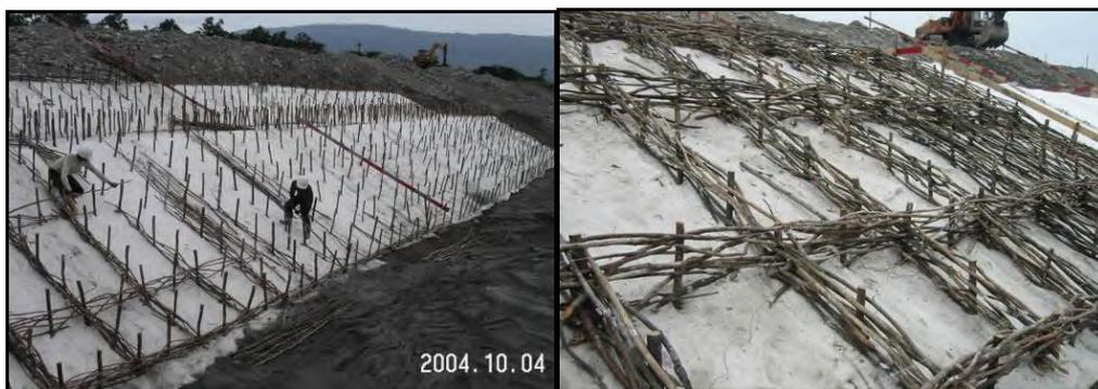
圖四編柵圖五編柵完成
