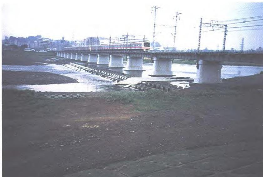
多摩川水系多摩川 京王電鐵路本線河床保護工程 全景
