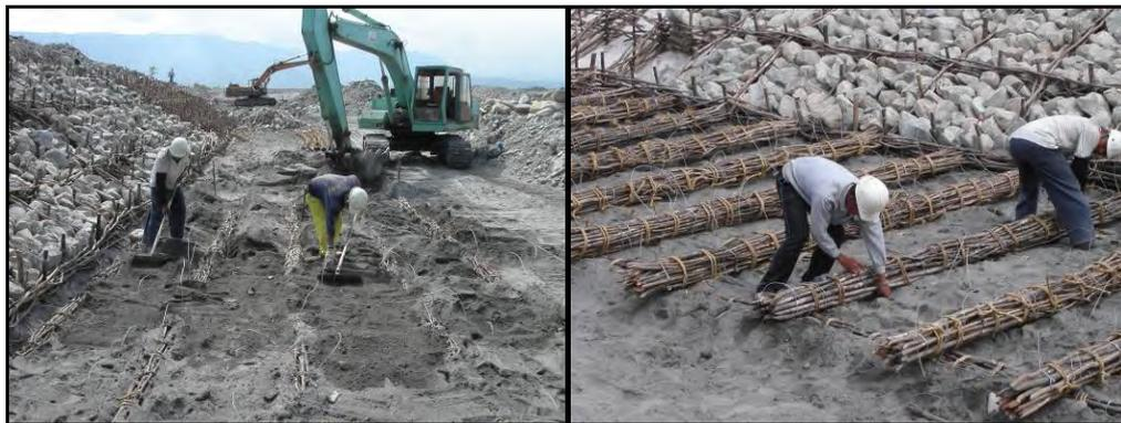
圖 15 砂土回填整平圖 16 橫向連材鋪設
