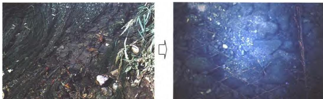
外露於河床的石籠材料，由於磨損而斷裂成銳利突出物，不論對魚類或對利用河流的人都具危險性。
