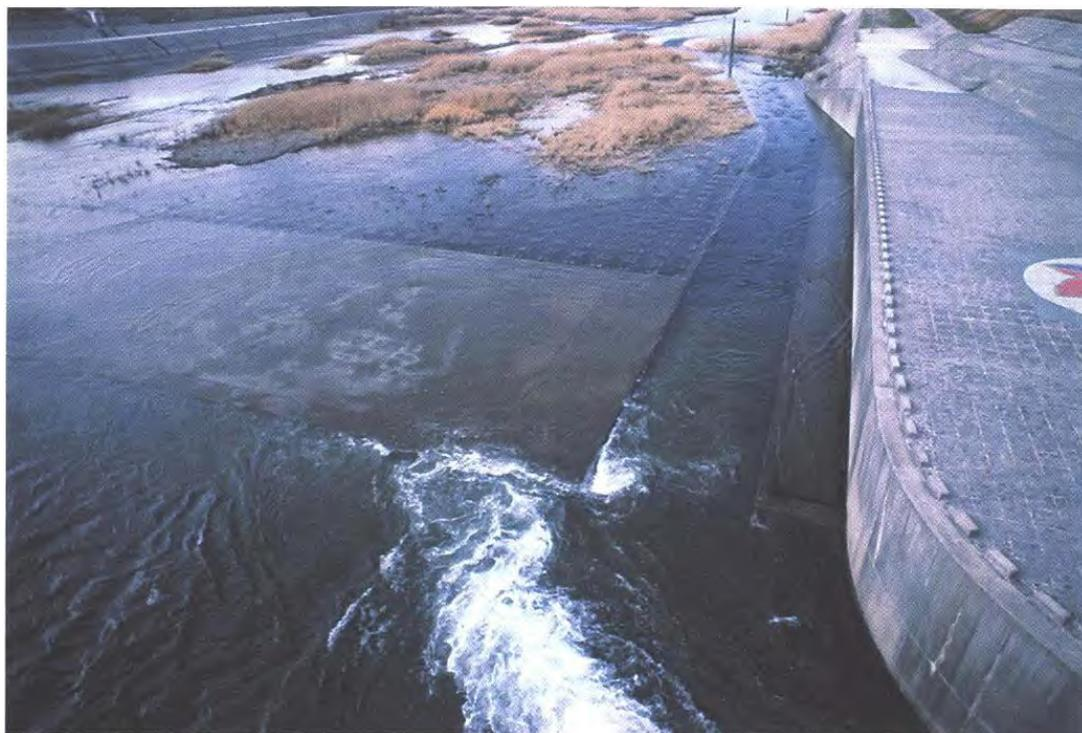
於魚道入口下游端周邊的保護河床工程表面設置凹部，形成明顯之引導水流，以利順利流入魚道下游端(上圖正前方右側)。此外透導水從遠處引入發揮誘導及防止誤入攔河堰正下方的機能。(山國川水系的山國川平成大堰)
