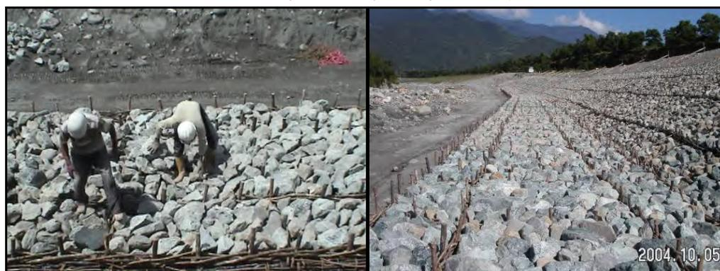
圖 21 角塊石排砌圖 22 完成後全景
