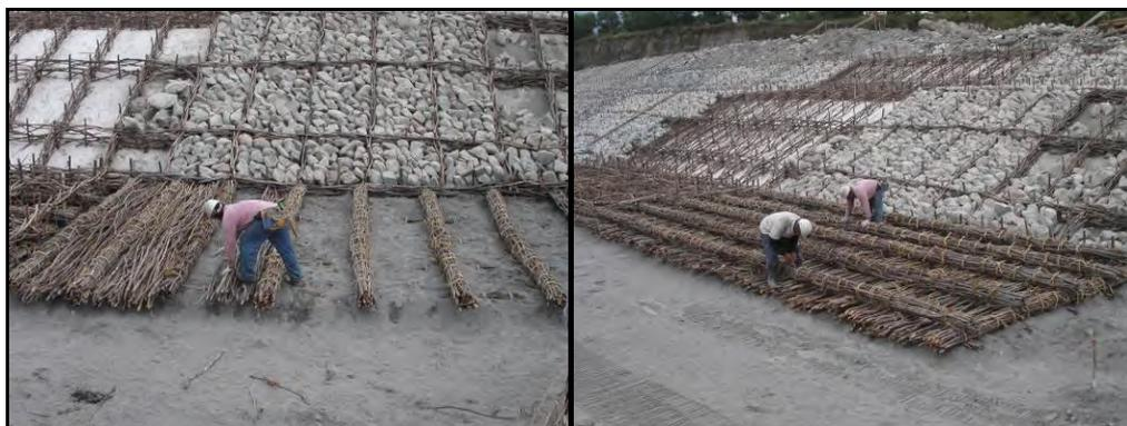
圖 17 鋪設雜木料圖 18 縱向連材鋪設
