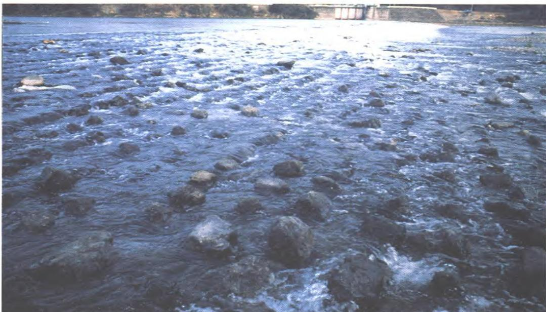
水道型全斷面式魚道的案例
