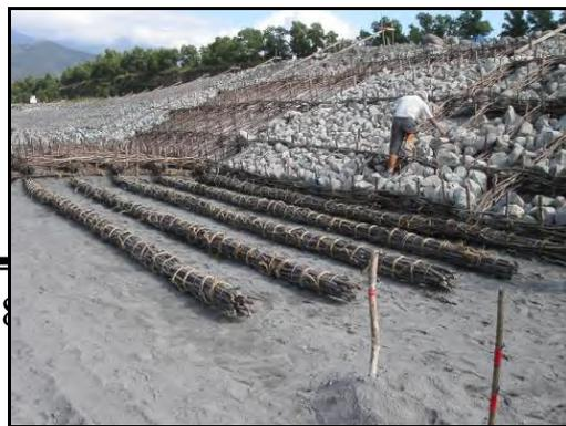
圖 13 河床整平圖 14 縱向連材鋪設
