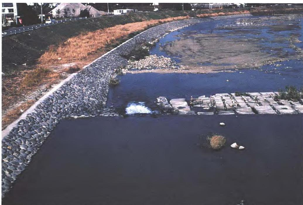
受魚道下游滯止水池的影響，魚道下端與止水池流向之間，形成 S 型的迴流現象。(室見川水系的室見川)
