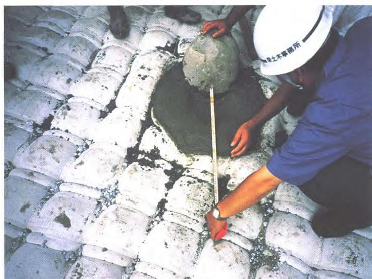
以布袋裝滿水泥的「鋪設粗石雙斜曲面式全斷面式魚道」。將垂直流向的主流改變為緩和斜流。由於從橋樑正下方及兩岸都無法找到可供作業的空地而採用本案形式。
