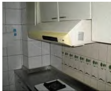
大多有燃燒行為，因廚房 空間不大，通風效果較差
