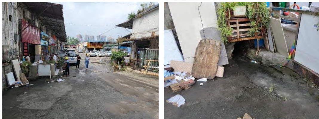
图 2-44 清新区新大地批发市场易涝点现场照片
