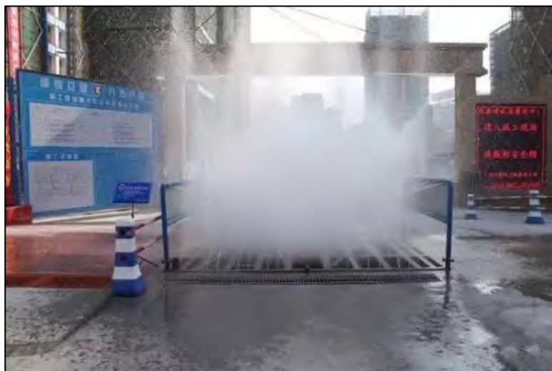
洗车装置喷水示例
