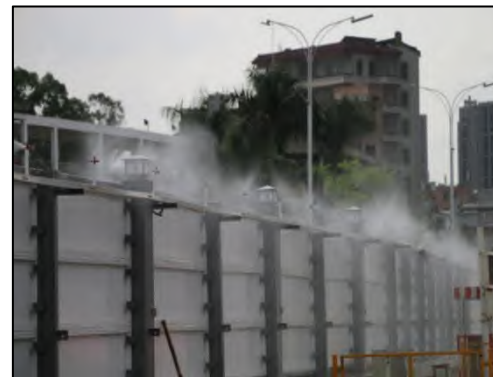
围挡喷雾示例图
