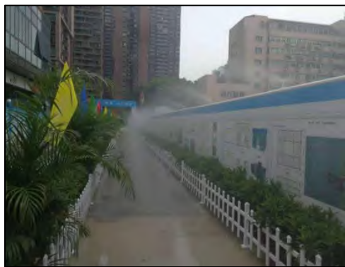
围挡喷雾示例图
