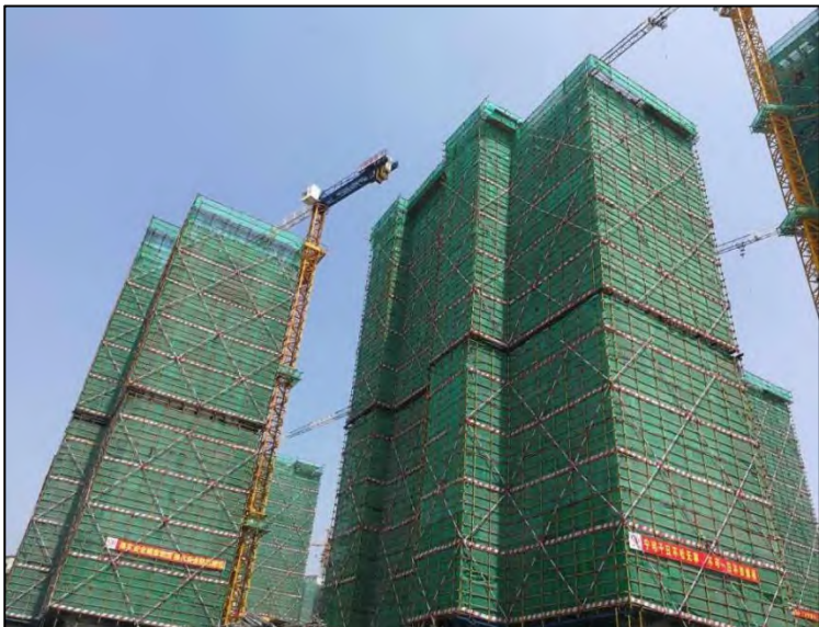
密目网(扣件式脚手架)防护使用实例图
