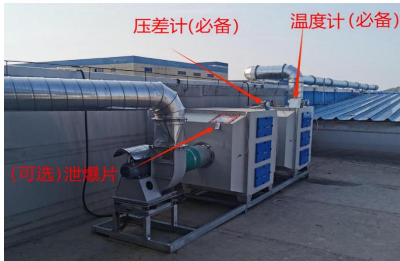
压差计、温度计安装示意图
