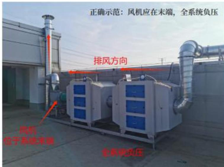
排放风机宜安装在吸附装置后端，使装置形成负压，尽量保证无污染气体泄漏到设备箱罐体体外。
