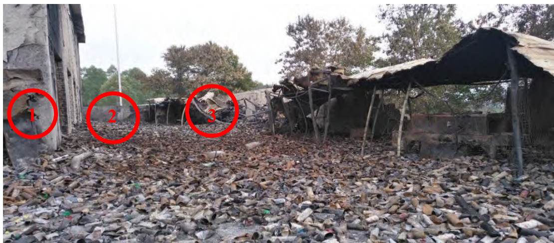
图 7 火灾后事故现场照片 ( 1-丙类仓库 B3; 2-戳罐作业区; 3-过膜作业区 )
