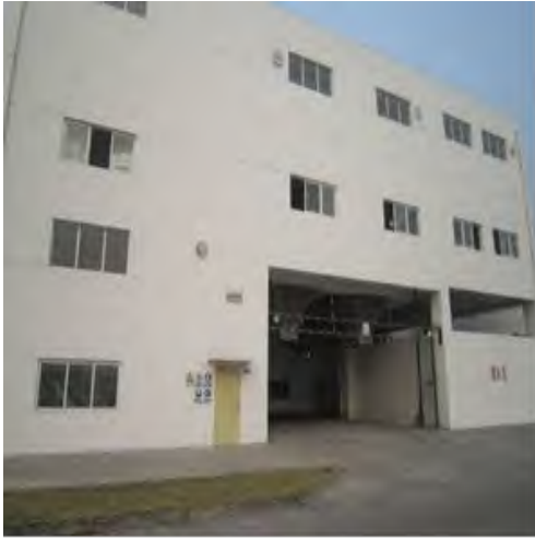
图 8-9 脱硫废水处理系统
