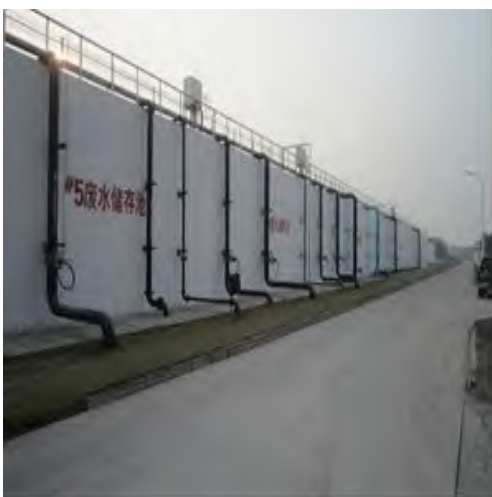
图 8-7 包括氨区废水在内的废水储存池
