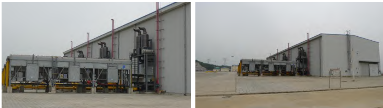
图 8.2-1 压缩机房及排气筒
