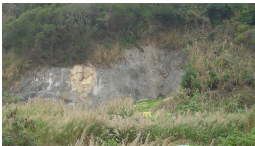
大铲岛隧道出口
