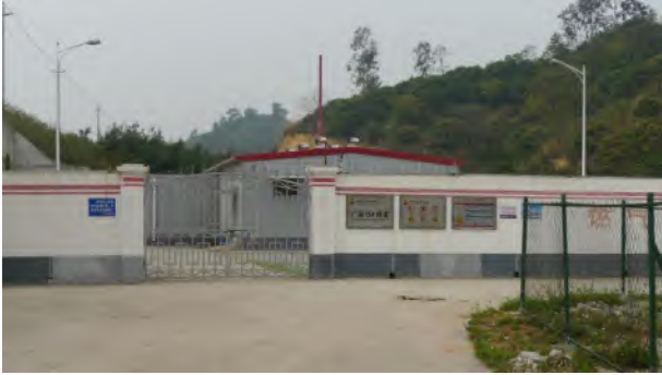
阀室设备置于室内且修筑高围墙
