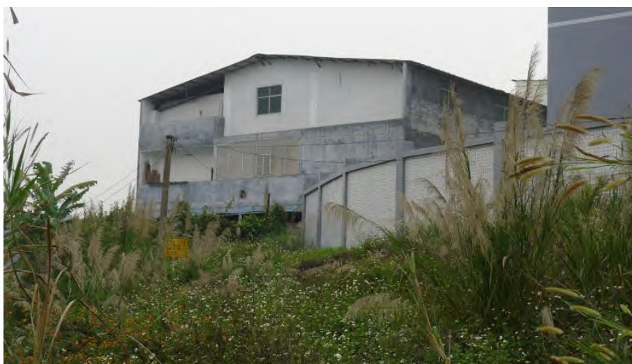
15 号阀室附近拆迁后的工厂, 距离管道 6.5m
