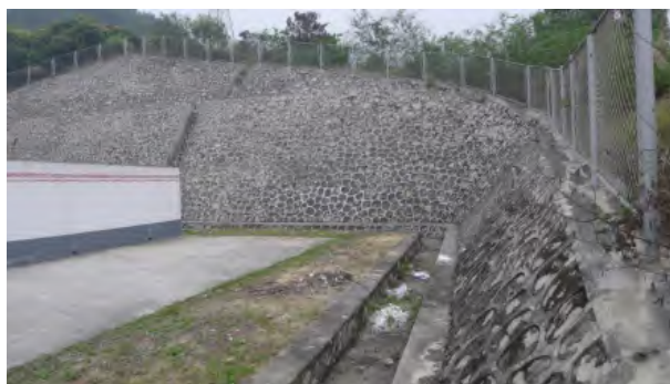
17号阀室护坡、排水管
