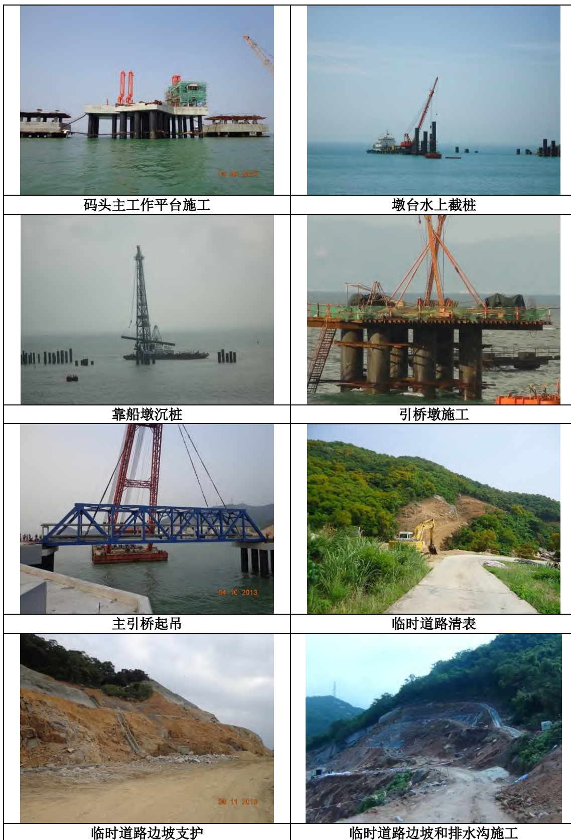
图 2.3-5 本工程施工期照片
