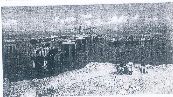
水工墩台施工情况
