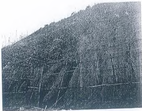
临时道路边坡施工
