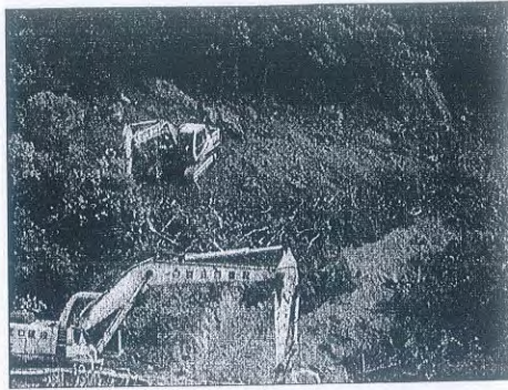
临时道路清表施工
