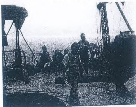
监理人员进行施工现场安全环保巡视
