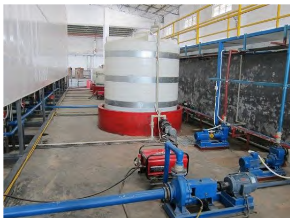
照片 7-19 储罐围堰
