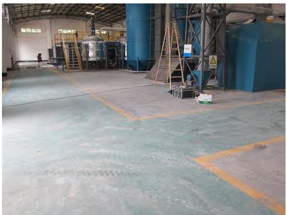
照片 7-14 无害化处理区地面防渗情况
