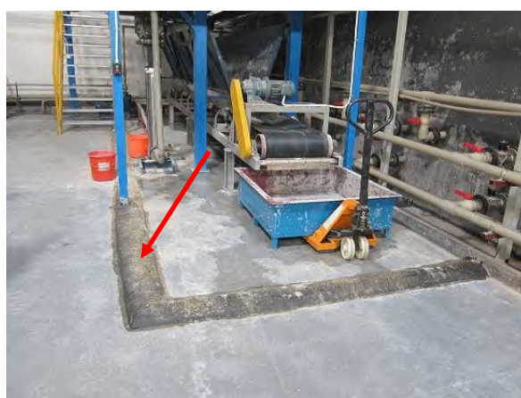
照片 7-18 无害化处理压滤区 防泄漏围堰
