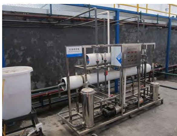
照片 3-4 生产废水反渗透系统
