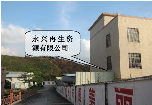
照片 7-36 项目西面厂界
