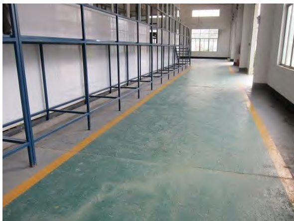
照片 7-13 清洗区地方防渗情况
