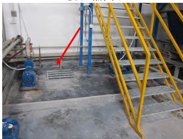
照片 7-20 车间地面废水收集池
