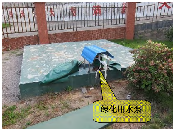
照片 3-1 生活污水收集池
