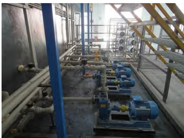
照片 7-11 水泵地面防渗漆
