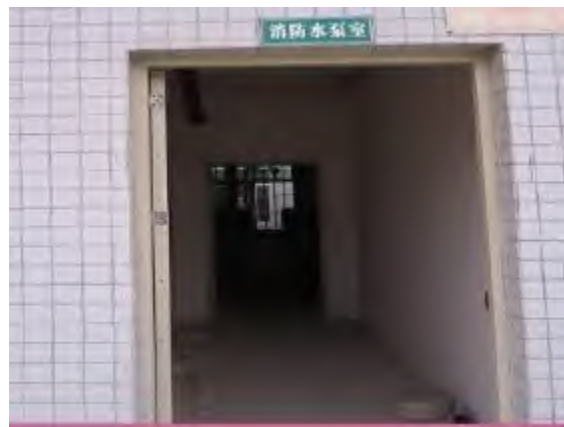
照片 9-25 消防水泵房
