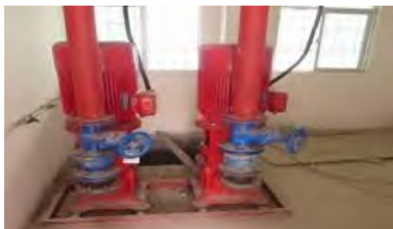
照片 9-26 地理式消防水池及泵
