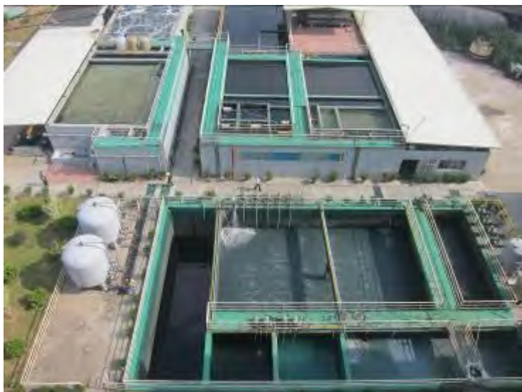
照片 4-1 项目废水处理站
