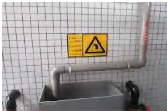
照片 9-17 一类污染物排放口
