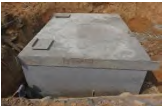
照片 9-19 雨水沉淀池
