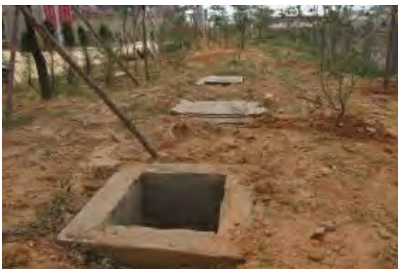
照片 9-17 厂区东侧雨水收集池
