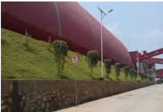
照片 9-25 厂区护坡
