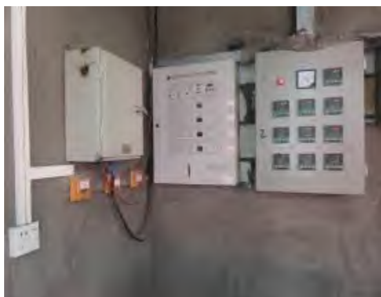
照片 9-11 煤磨系统 CO 自动监测装置
