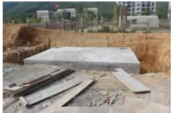
照片 9-18 厂区西侧雨水收集池
