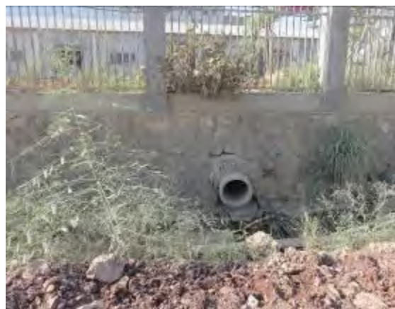
照片 8-5 雨水排放口
