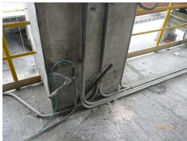
照片 9-7 穿钢管导线
