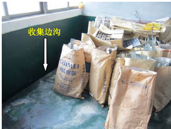
照片 9-35 危废仓库内收集边沟
