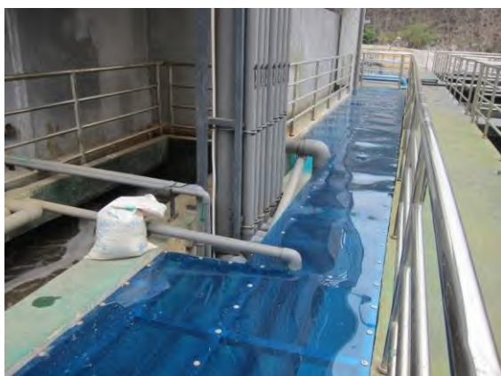
照片 9-64 污水处理机泵隔声罩
