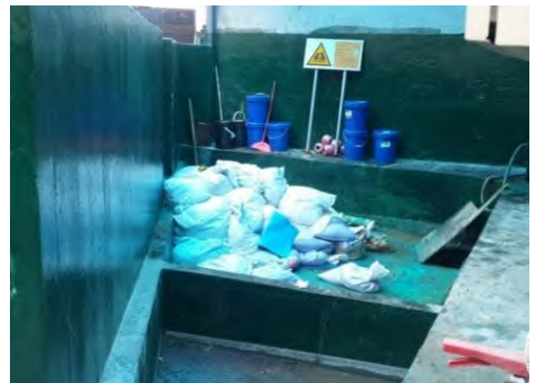
照片 9-40 污水处理污泥贮存池
