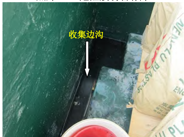
照片 9-36 危废仓库内收集边沟
