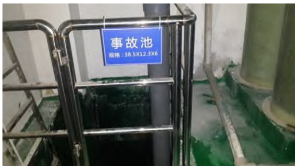
照片 9-30 事故池 (约 3000m 3 )
