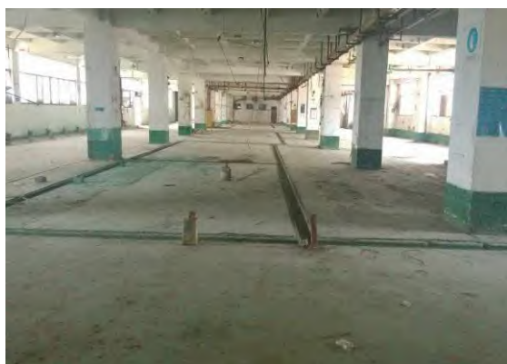
照片 9-52 鹅岭旧厂现状 (1)
