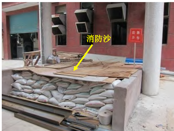
照片 9-26 外供药区旁应急沙池
