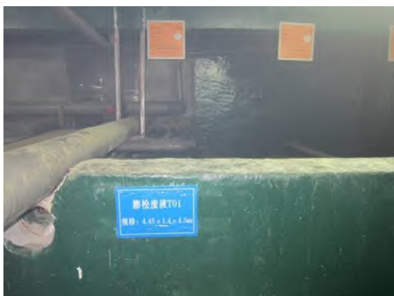
照片 9-42 废液储存池 (1)
