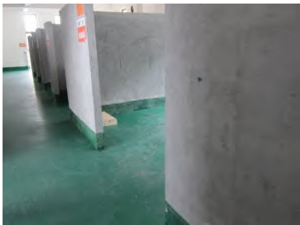
照片 9-34 危险废物暂存库
