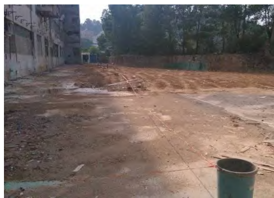
照片 9-53 鹅岭旧厂现状 (2)
