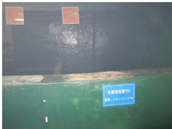
照片 9-43 废液储存池 (2)
