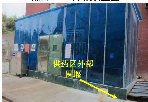
照片 9-24 中央供药外供药区
