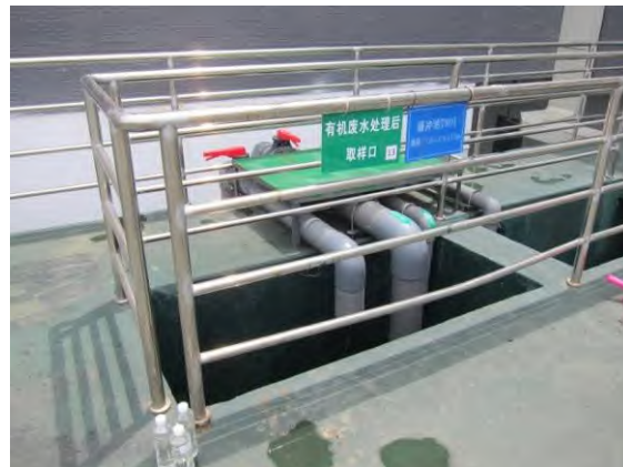
照片 9-61 污水处理站防渗地面
