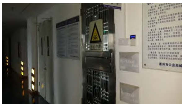
照片 9-33 氰化金钾仓库
