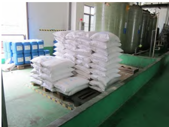
照片 9-62 物料堆放场所防渗地面
