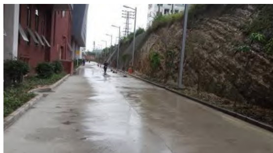
照片 9-21 消防通道
