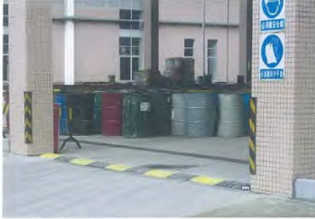
附件 3: 3、4#危险废物堆放场所及稳定固化车间、物化车间等建筑物地面出入口围堰设施现场照片
