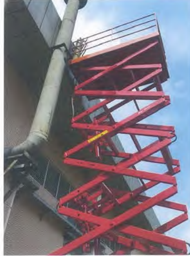
附件 1：破碎工序配套除尘设施废气排气筒的监测平台及监测孔现场照片
