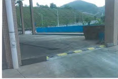
附件 3: 3、4#危险废物堆放场所及稳定固化车间、物化车间等建筑物地面出入口围堰设施现场照片
