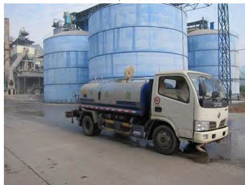
图 9-8 成品水泥储存库
