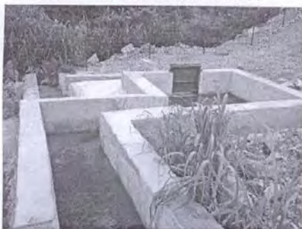
图 2-11 整改后 3#排雨口闸门
