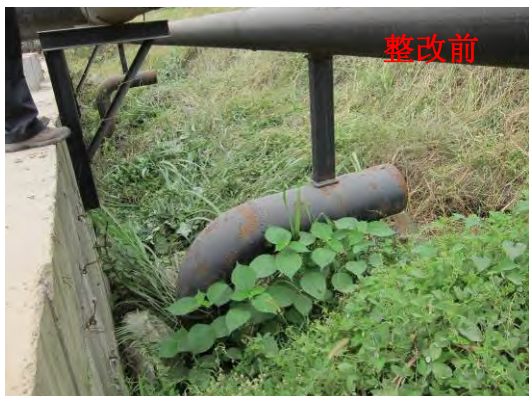
图 9-19 联合水泵站水池通气口存在外排水现象
