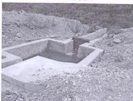
图 2-10 整改后 1#2#排雨口闸门
