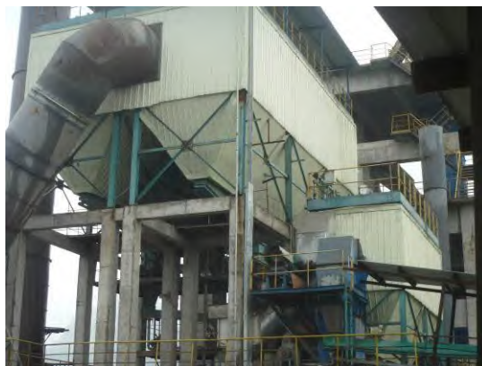
水泥管磨屋顶除尘器
