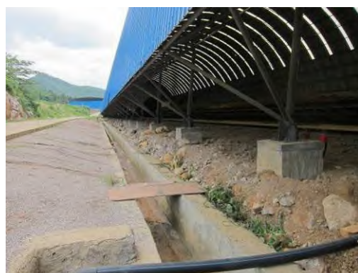
图 9-6 长形原煤/辅料预均化堆场
