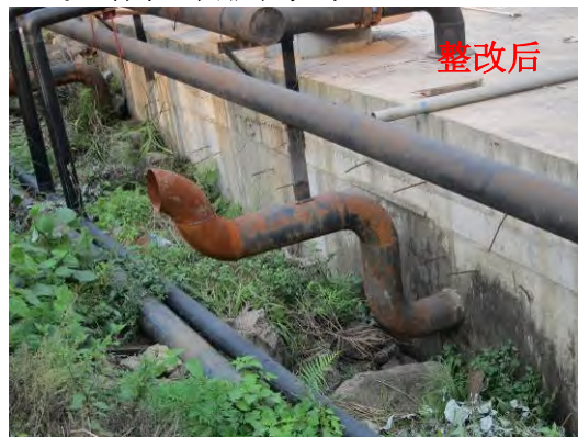
图 9-20 联合水泵站水池通气口整改情况（未见外排水现象）
