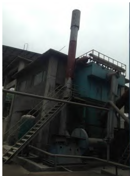
图 8-3 1-030 除尘器排气筒 (整改后)
