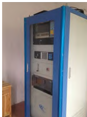
图 9-18 窑头烟气在线装置
