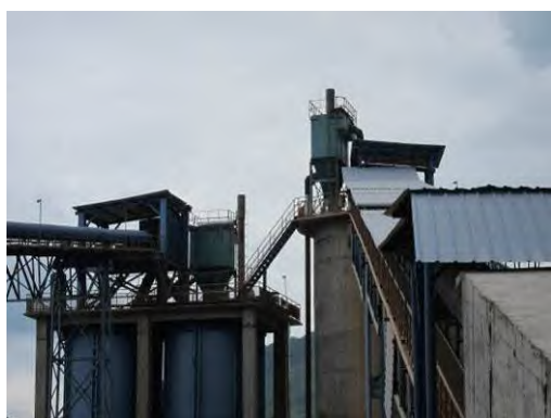
图 9-5 石灰石圆库和砂岩圆库
