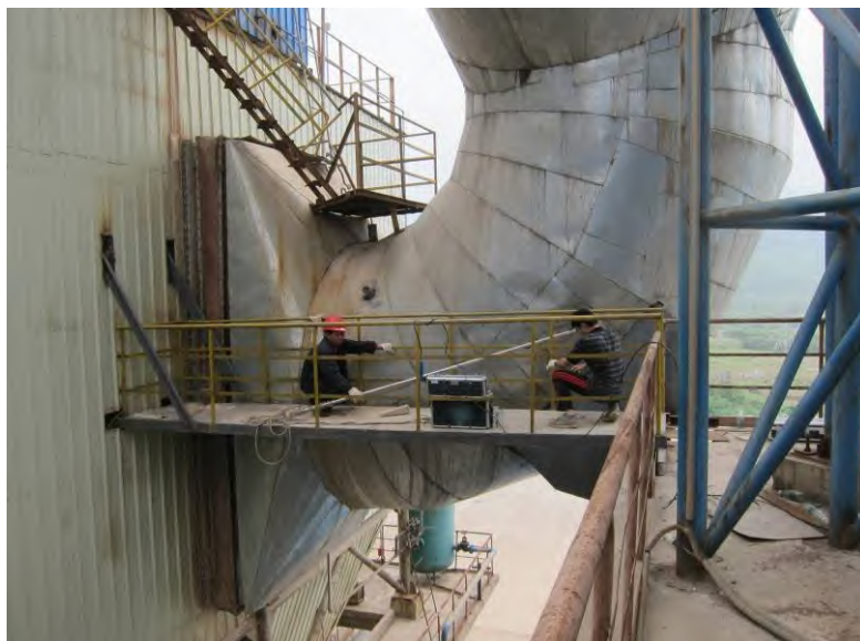
图 8-1 窑尾除尘器进口监测孔设置不规范
