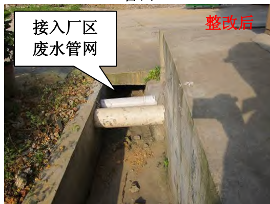
图 9-26 办公楼外废水外排整改情况
