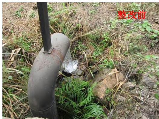
图 9-19 联合水泵站水池通气口存在外排水现象
