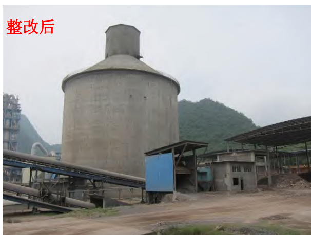
图 9-14 石膏破碎上料口无漏尘现象
