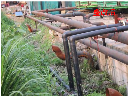
图 9-20 联合水泵站水池通气口整改情况（未见外排水现象）
