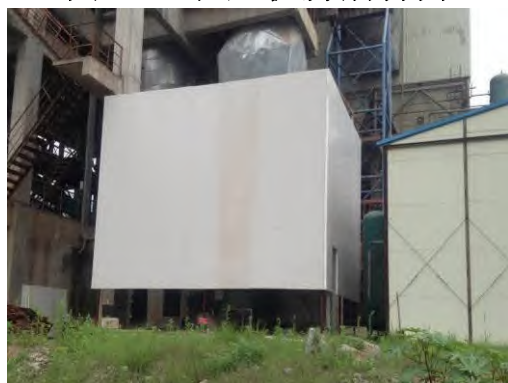
图 8-6 生料立磨电机隔音板
