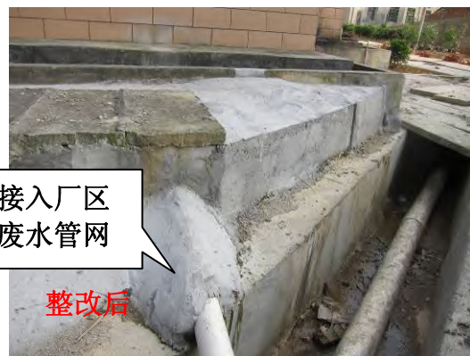
图 9-24 职工食堂厨余废水接入厂区管网
