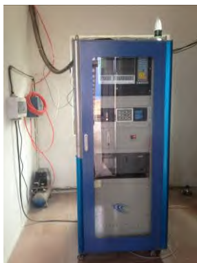
图 9-17 窑尾烟气在线装置
