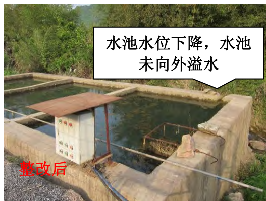
图 9-22 厂区内水池溢水整改情况
