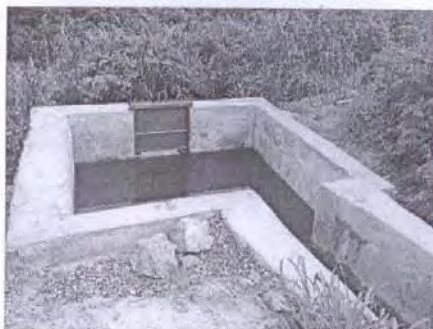
图 2-13 整改后 5#排雨口闸门
