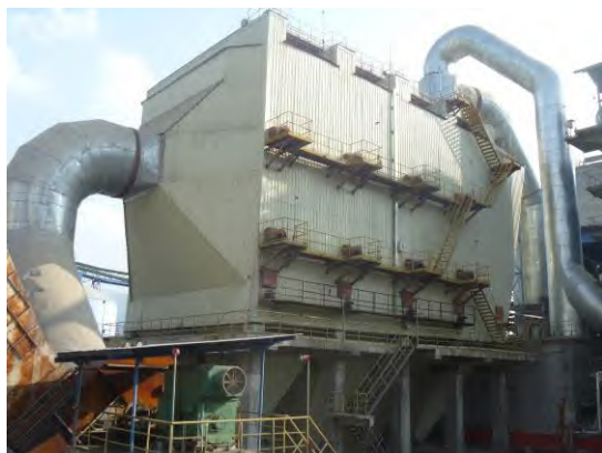
窑头电除尘器
