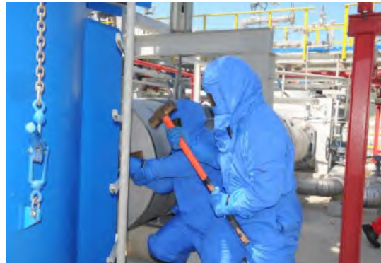
维保组进行抢修堵漏演练
