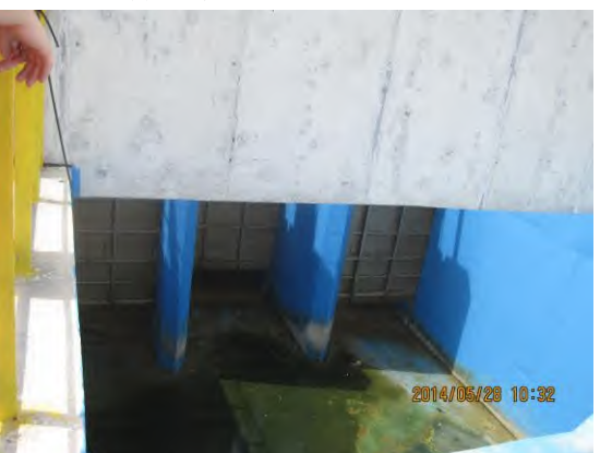
冷排水排放口
