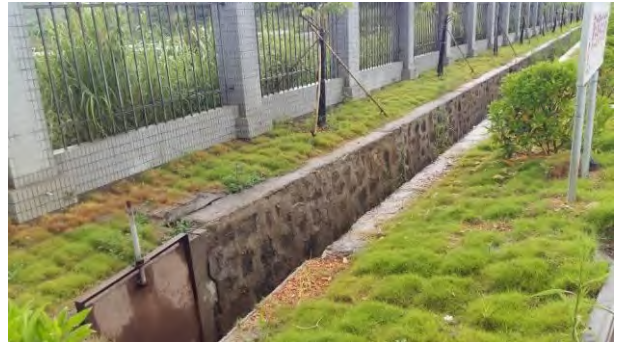
照片 12 厂区雨水收集沟
