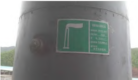
照片 3 煤粉制备排口
