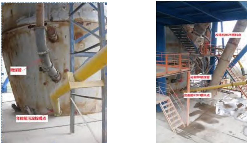
照片 16 污泥喂料点改造
