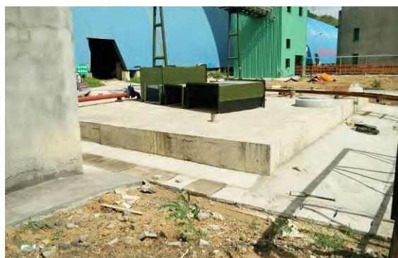
照片 19 事故应急和消防水缓冲池
