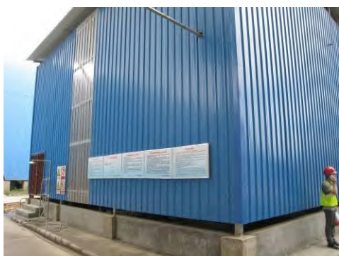
照片 20 氨罐区围堰
