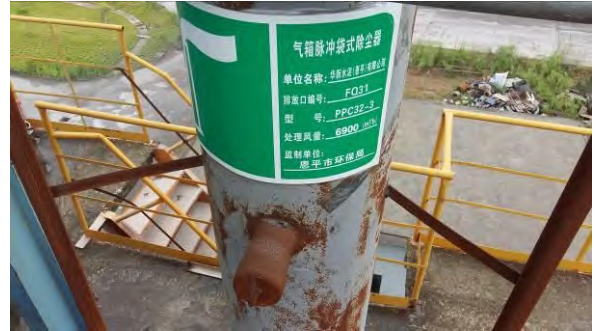
照片 2 石膏混合材破碎排口
