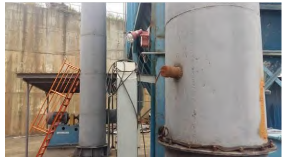
照片 4 石灰石破碎排口
