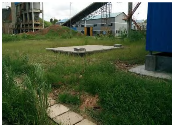
照片 22 氨罐应急池
