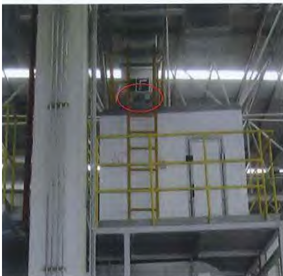
5、尾气抽排房开孔 远景
