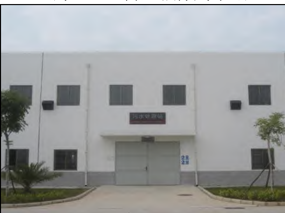
照片 9-6 污水处理站
