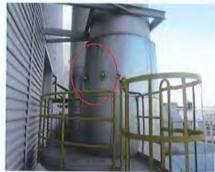
4.2、RTO 焚烧炉进出口开孔 近景
