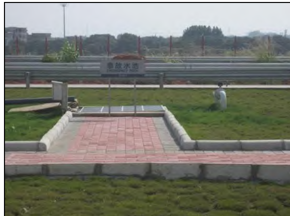
照片 9-44 废水站事故池
