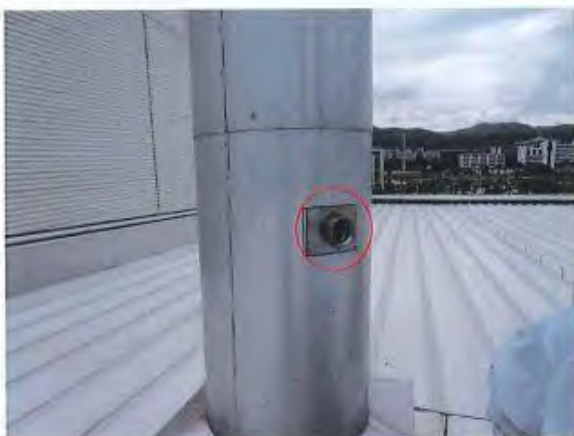
2.1、涂装屋面 开孔近景
