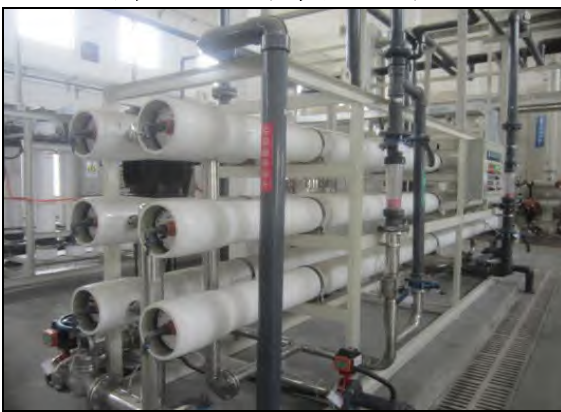
照片 9-8 超滤反渗透系统
