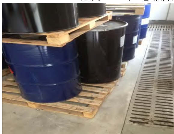
照片 9-41 危废存放间截流沟
