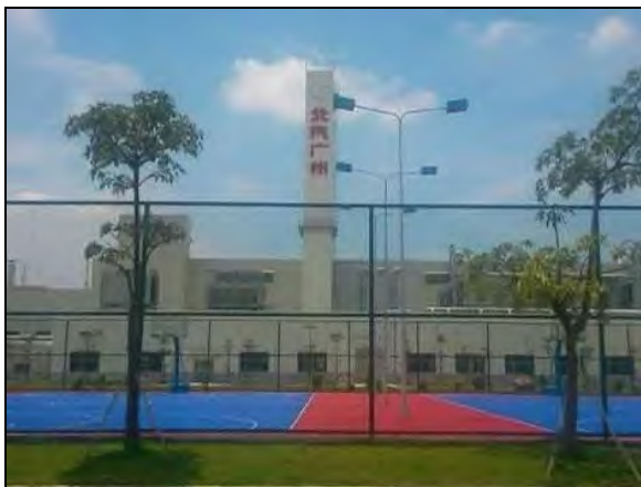
照片 9-3 涂装车间涂装排气筒
