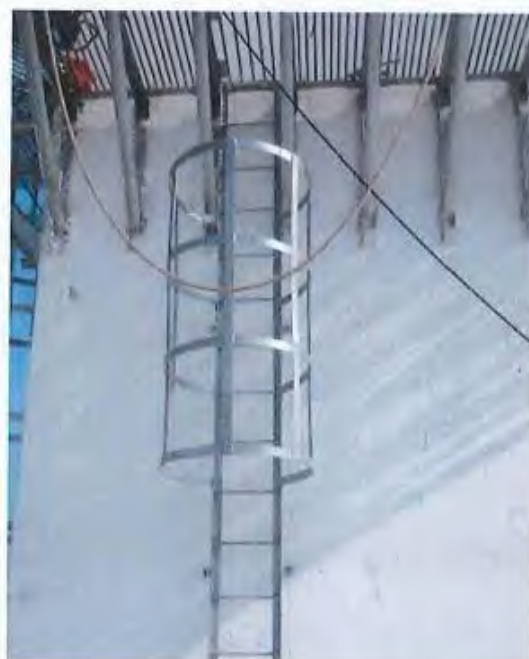
9.2、涂装废气排气筒南侧护笼爬梯
