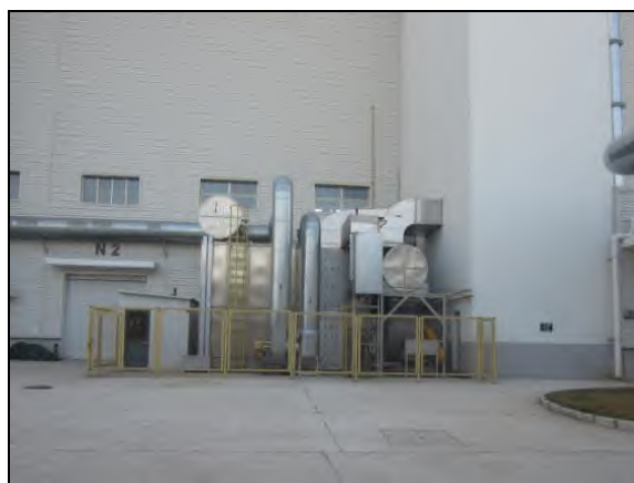
照片 9-2 涂装车间转轮浓缩装置
