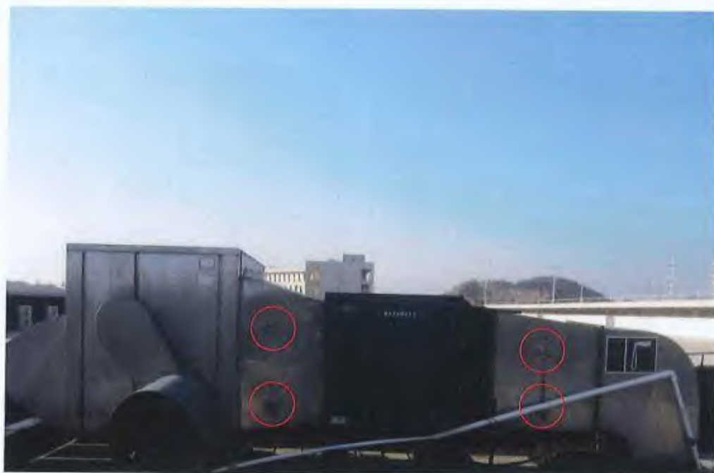
8、食堂油烟净化系统开孔
