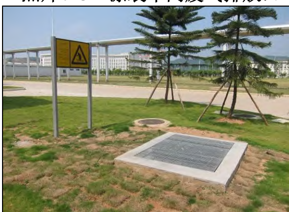
照片 9-33 废水总排放口
