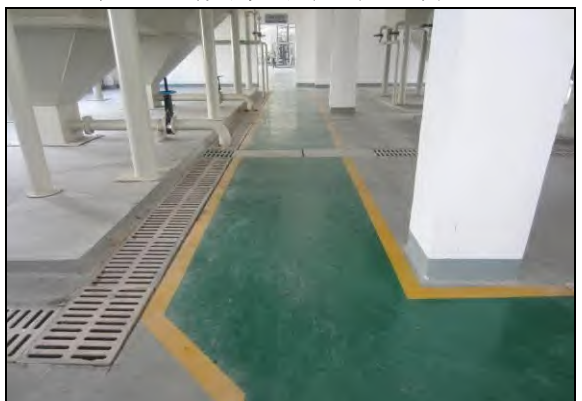
照片 9-50 废水站防腐地坪
