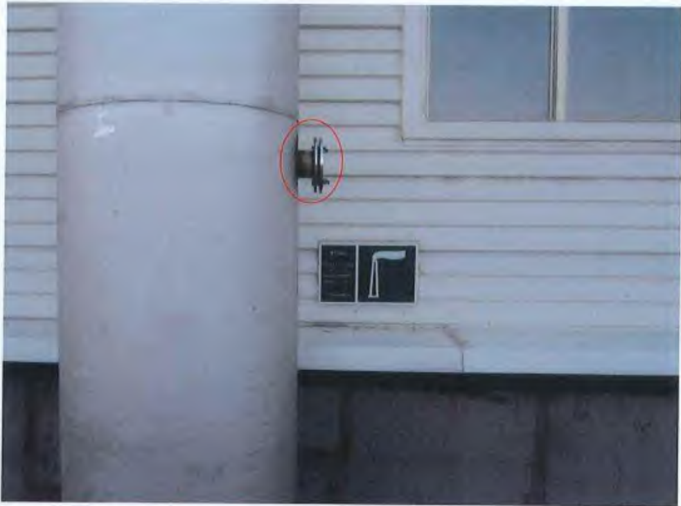
3.1、锅炉房排气筒开孔
