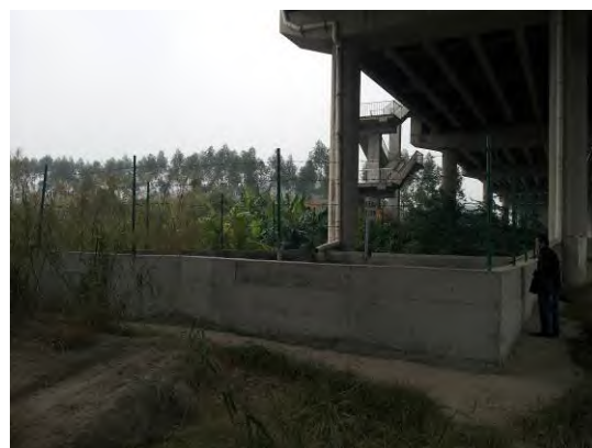
黄田绥江大桥集水管+收集池
