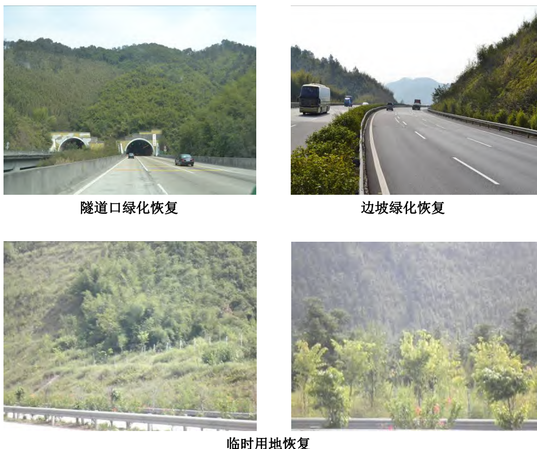
图 5.3-2 广宁竹海国家森林公园路段施工迹地恢复情况
