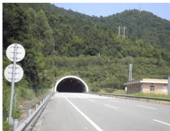
凤山隧道出口
