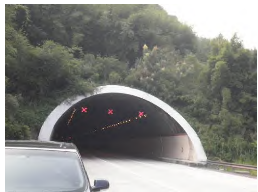
隧道洞口绿化
