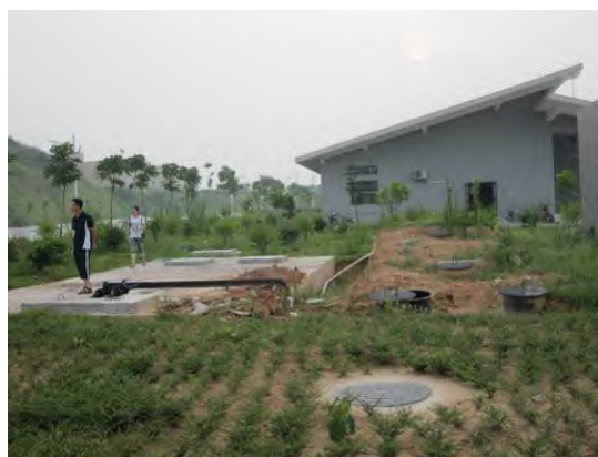
龙甫服务区（四会管理站）
