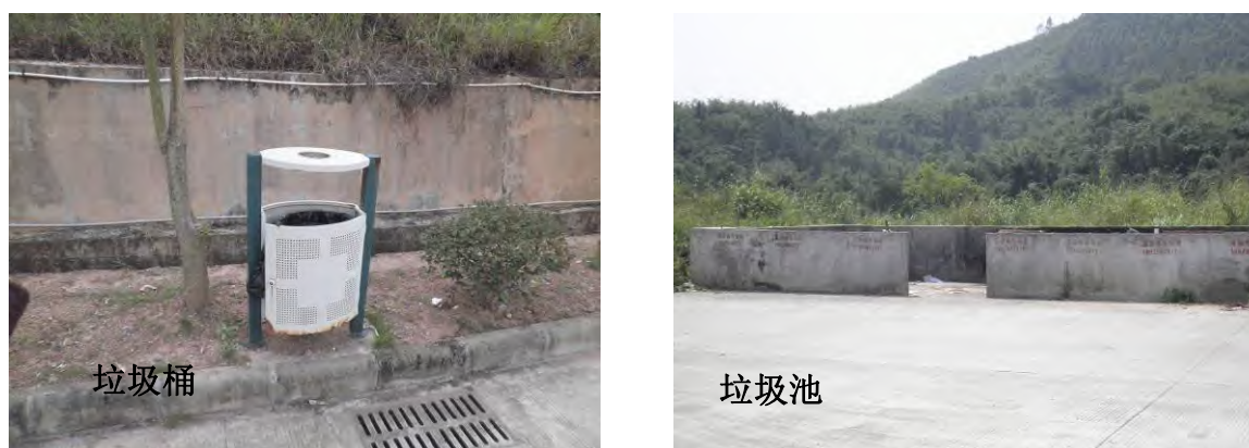
图 8.3-1 沿线服务设施站点生活垃圾收集设施
