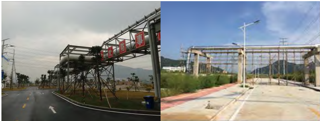
照片 6-1 厂内建设供热管网
