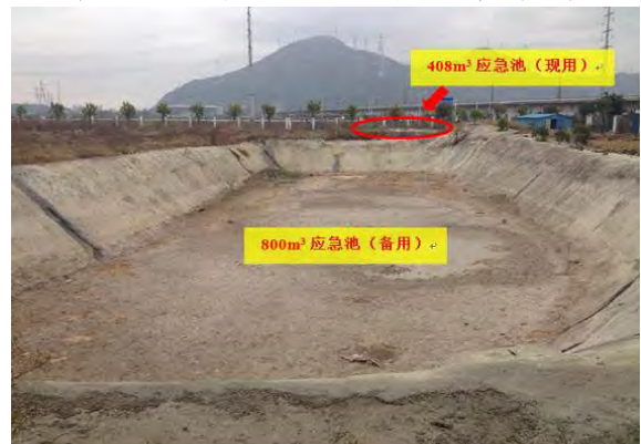
照片 7-12 备用 800m 3 应急池
