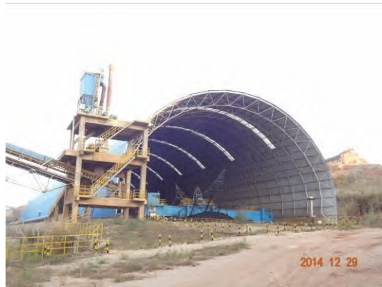
半封闭燃煤堆棚
