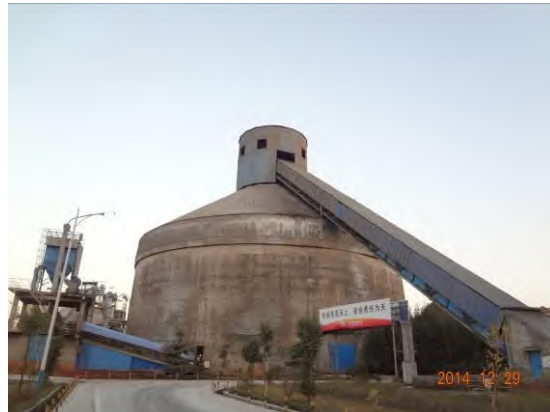
封闭式熟料库
