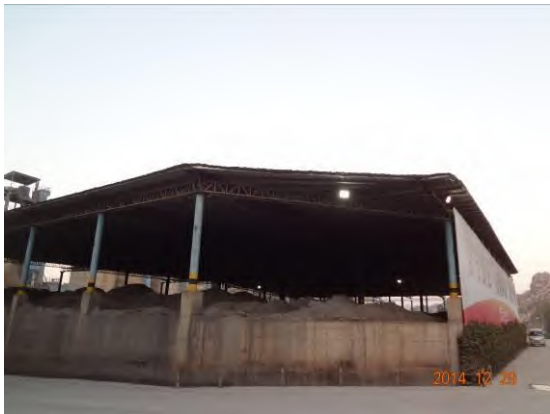
半封闭混合材堆棚
