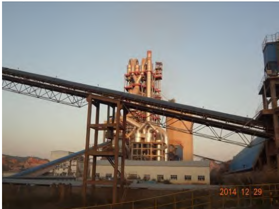
全封闭煤输送带
