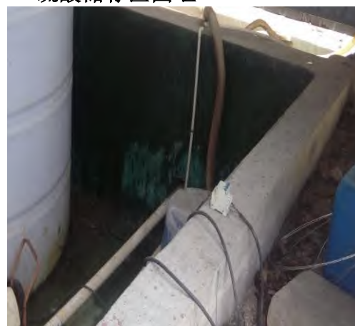
半地下原料储存区围堰 1
