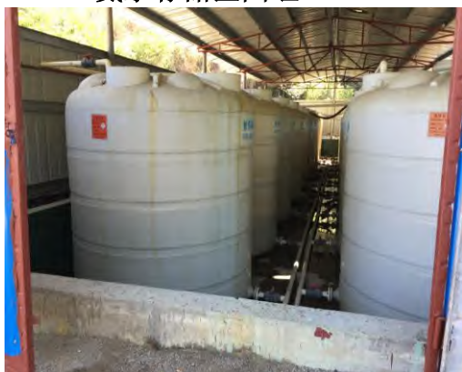
半地下原料罐区围堰及应急卸料槽
