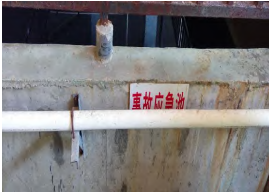
废水站事故应急池 1
