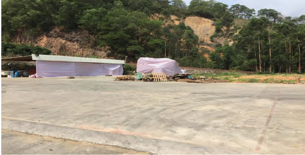
一般固废临时暂存间
