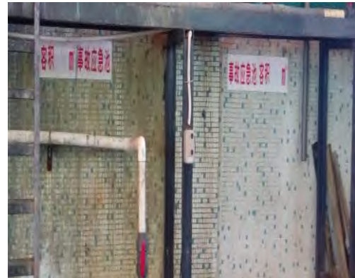
废水站事故应急池 2
