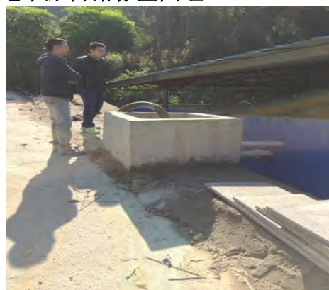
半地下原料罐区围堰及应急卸料槽
