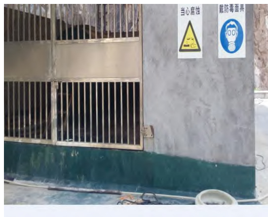
硫酸储存区围堰
