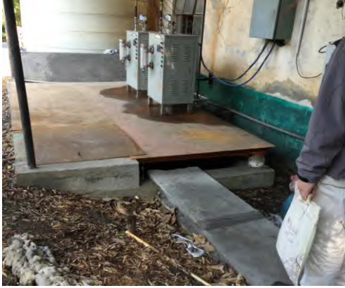
氨水罐区应急池
