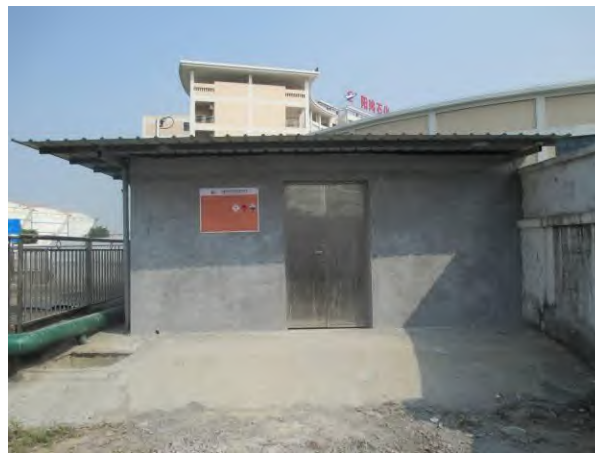
危废暂存库外部
