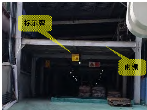
照片 7-2 危险废物暂存场
