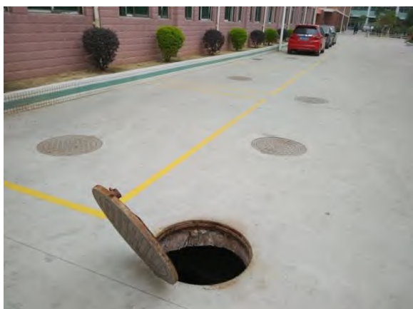
照片3-1 生活区化粪池
