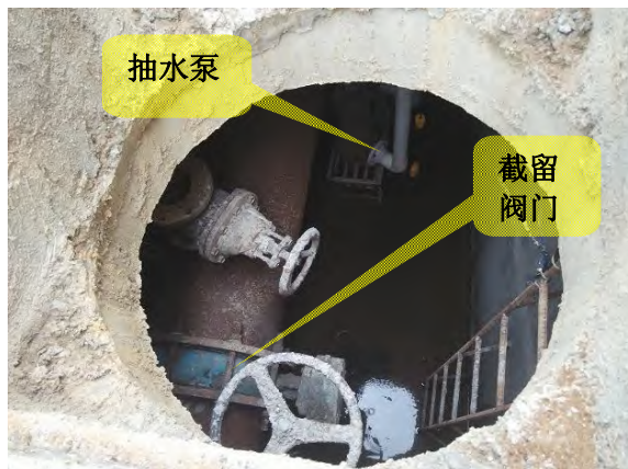
照片 7-18 雨水缓冲池截留阀门
