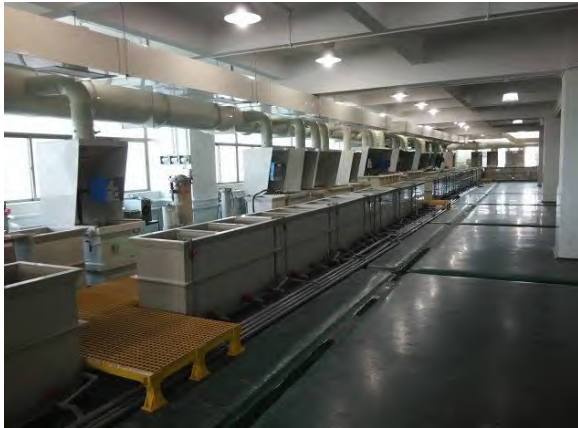
照片 7-21 电镀车间地面放泄漏收集沟
