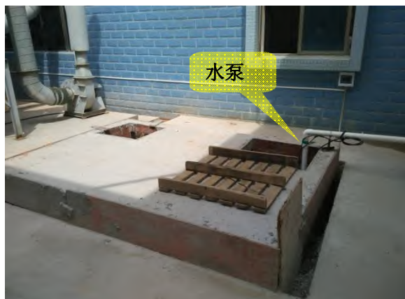
照片 6-1 研磨车间废水收集池
