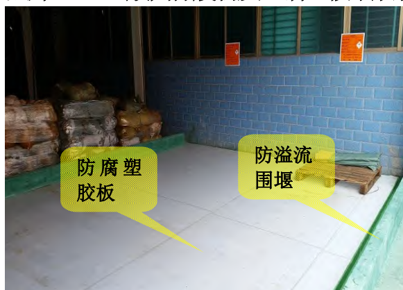
照片 7-3 危险废物暂存场内部情况
