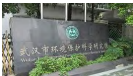
图 1. 测定对象墙壁（2012 年 7 月中旬 施工）
