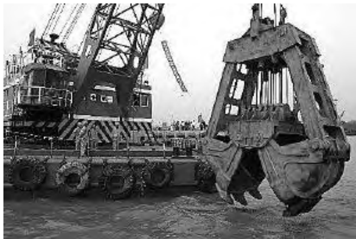
长江最大清淤船“海翔号”挖泥船(8m 3 )
