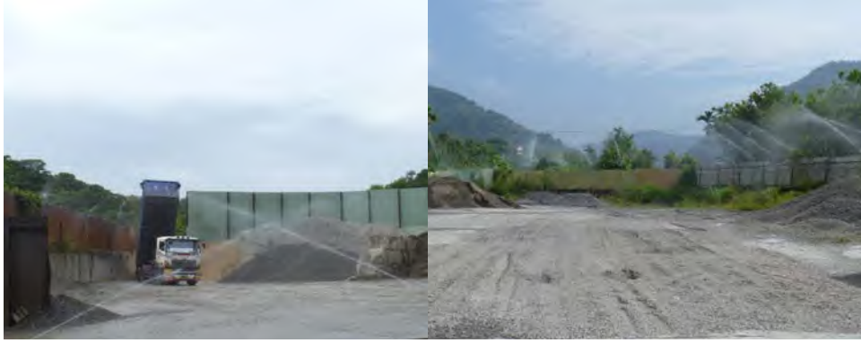
圖3-3 設置鐵皮擋風屏實照
