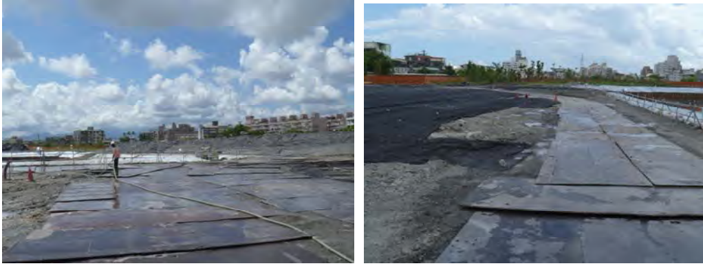
圖3-7 鋪設鋼板實照
