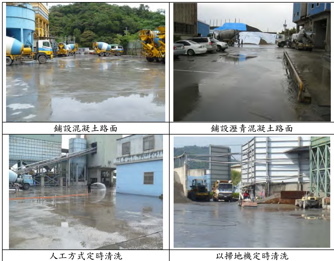
圖3-16 鋪設混凝土及瀝青混凝土實照
