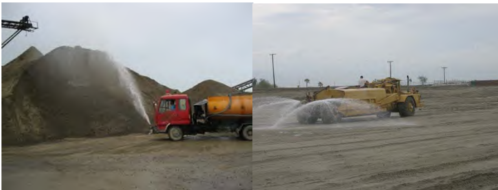
圖3-12 採行灑水車灑水實照
