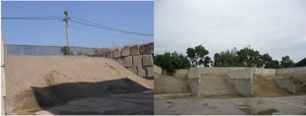
圖3-2 設置混凝土擋風牆實照
