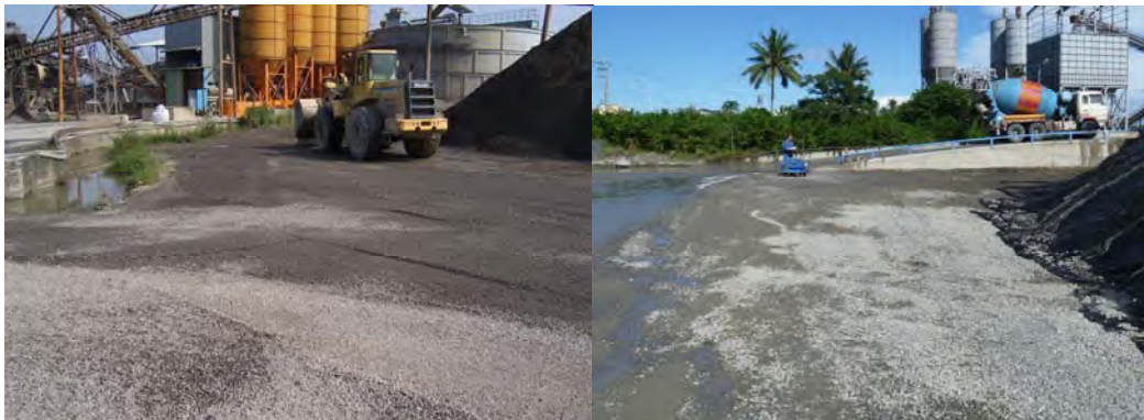
圖3-8 鋪設粗級配實照
