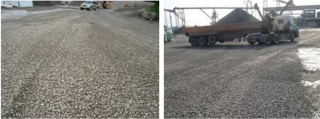
圖3-8 鋪設粗級配實照
