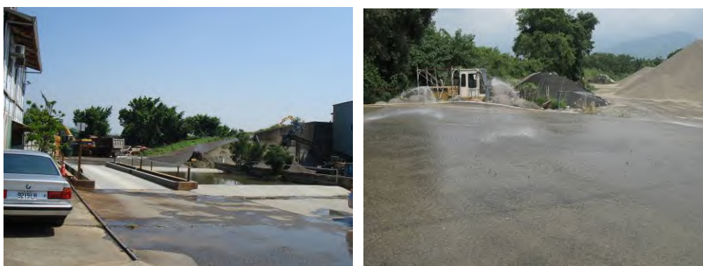
圖3-16 鋪設混凝土及瀝青混凝土實照
