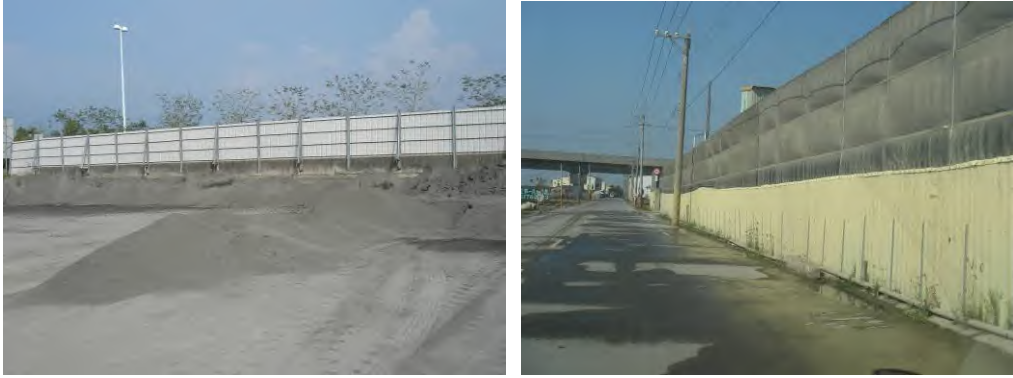
圖3-3 設置鐵皮擋風屏實照
