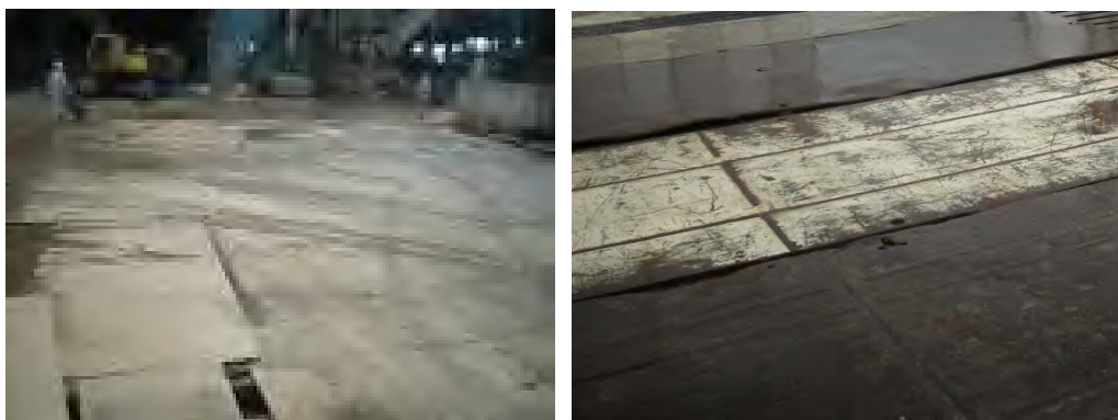
圖3-7 鋪設鋼板實照
