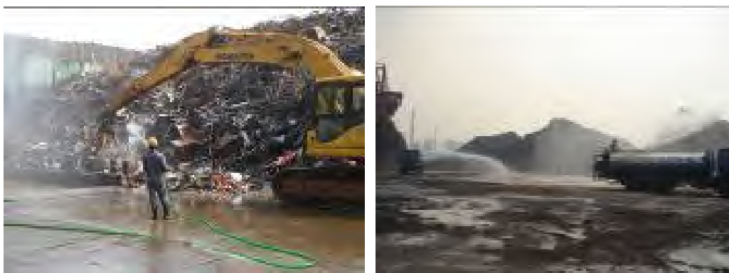
圖3-9 採行人工灑水實照
