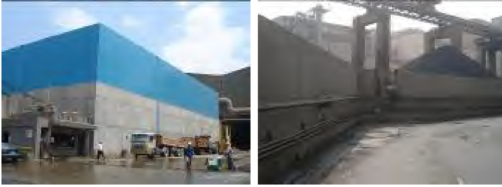
圖3-2 設置混凝土擋風牆實照
