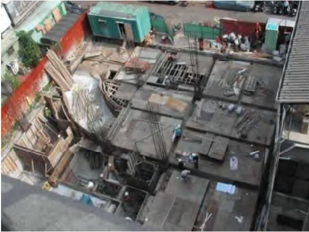
建造階段（施工中）
