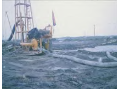
圖 8 反循環工法
