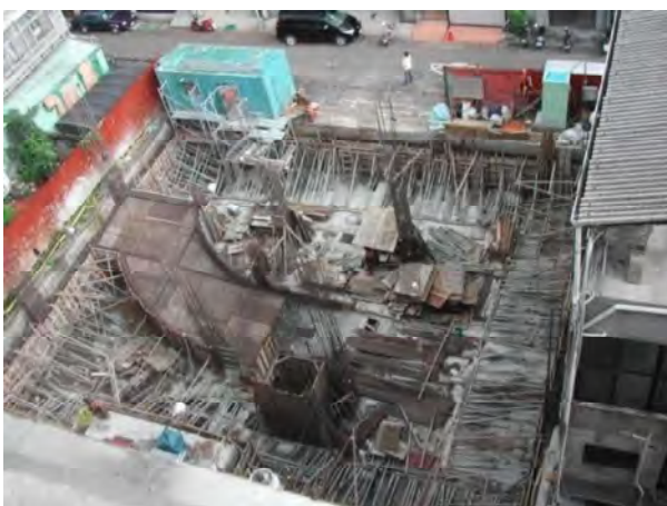
建造階段（施工前）
