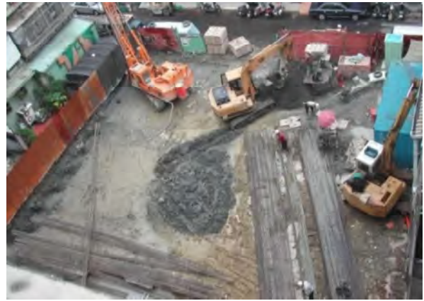
基礎階段（施工中）
