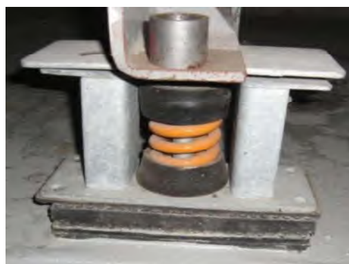
圖 13 機座底部加裝防振設備
