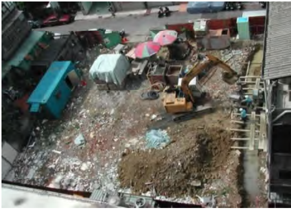
基礎階段（施工前）
