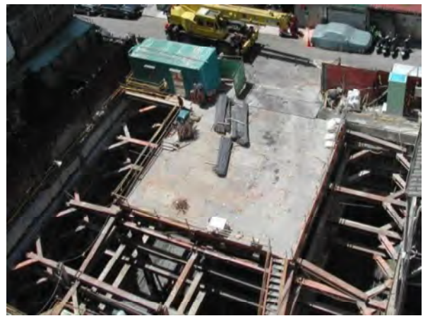
基礎階段（施工後）
