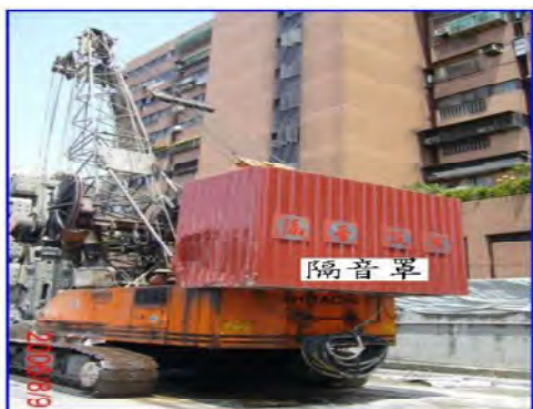
圖 12 機具部分設備加裝隔音罩
