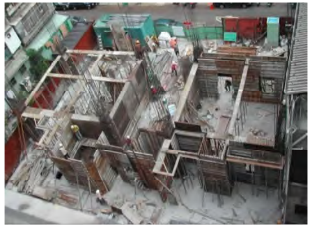
建造階段（施工中）
