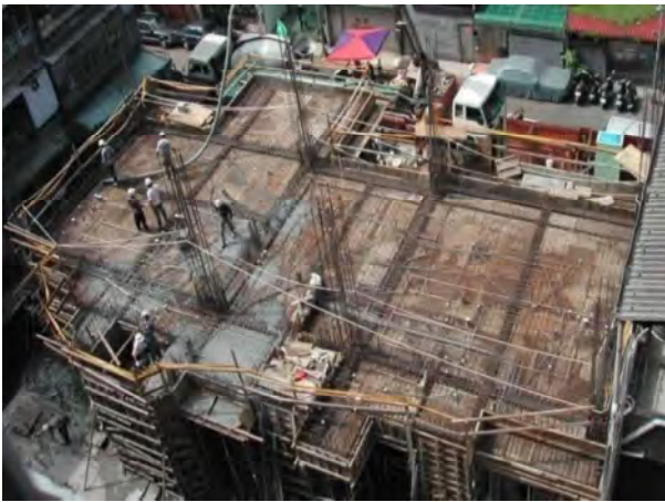
建造階段（施工中）
