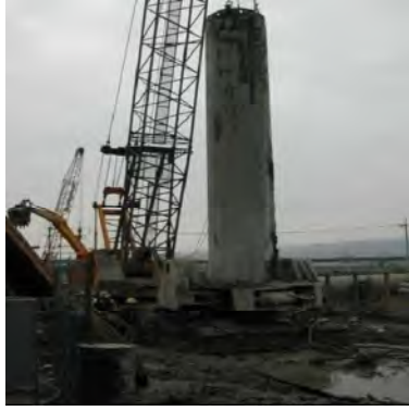
圖 7 全套管工法
