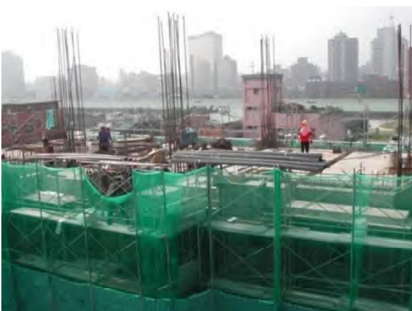
建造階段（施工後）
