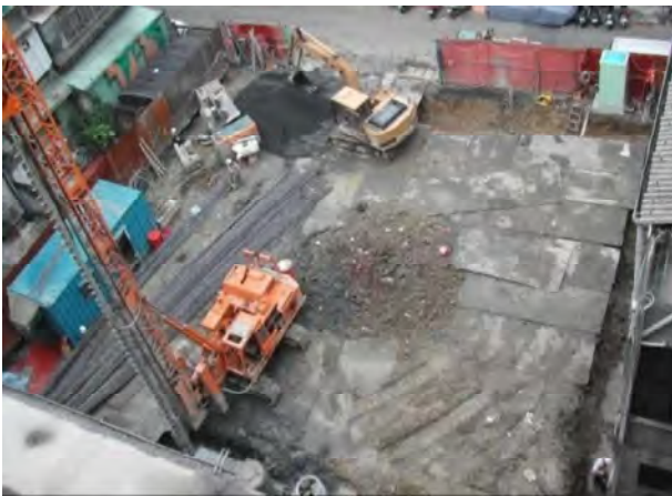
基礎階段（施工中）
