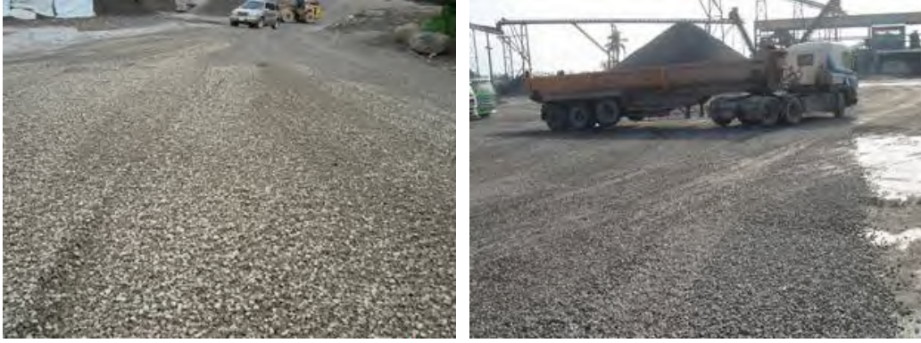
圖3-8 鋪設粗級配實照
