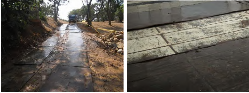
圖3-7 鋪設鋼板實照
