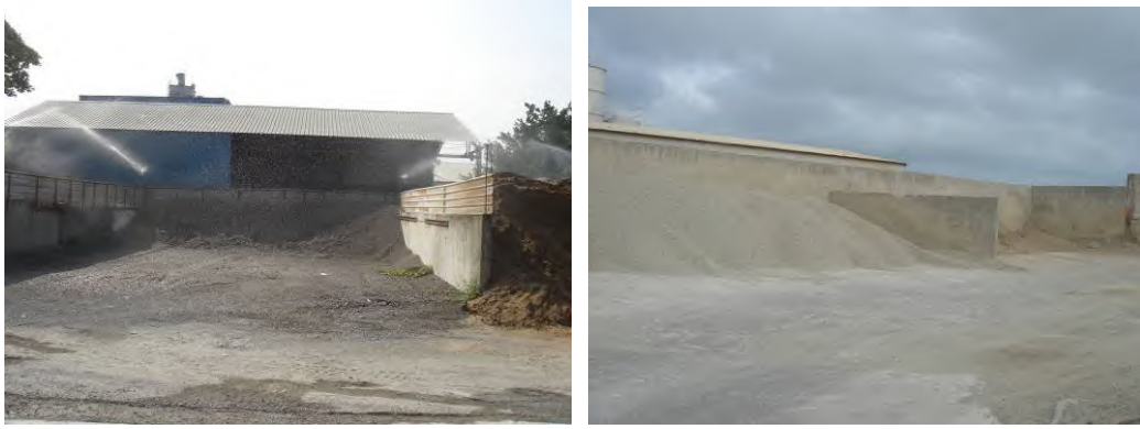
圖3-2 設置混凝土擋風牆實照
