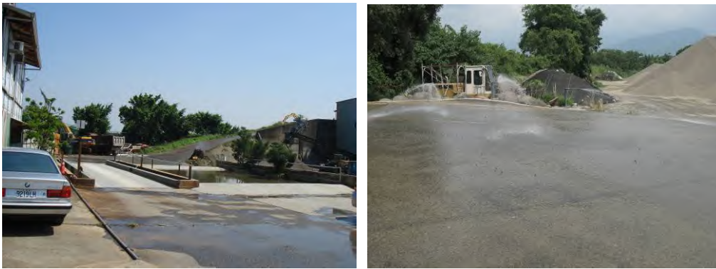
圖3-16 鋪設混凝土及瀝青混凝土實照
