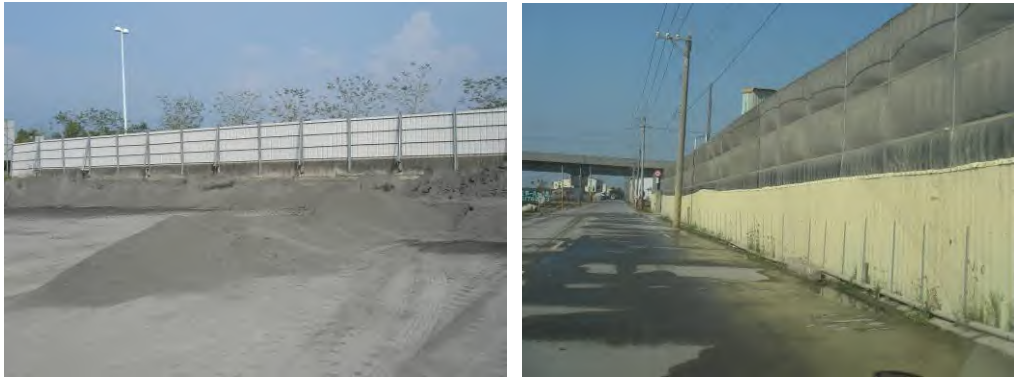
圖3-3 設置鐵皮擋風屏實照
