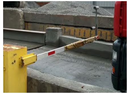
於自動洗車設備出口裝設閘門
