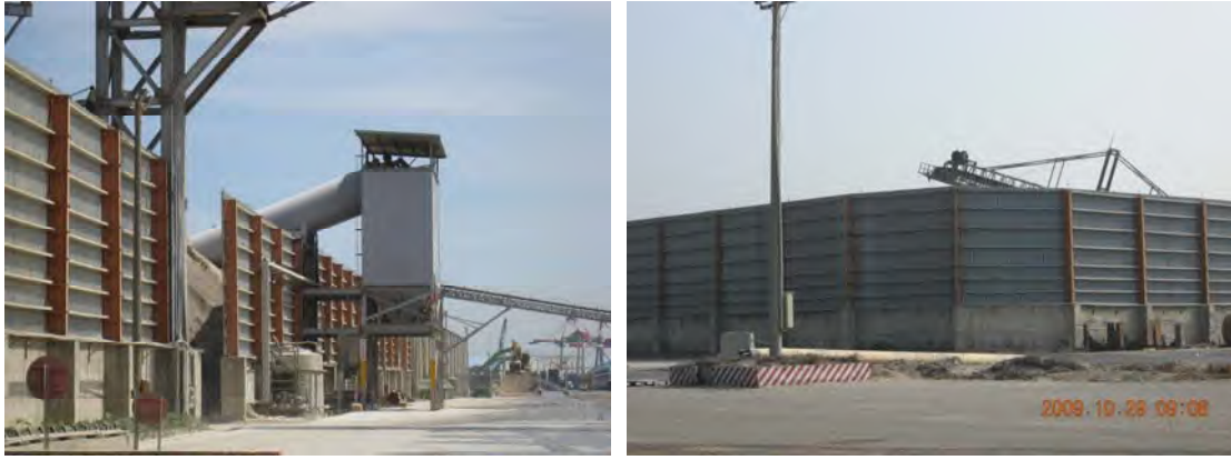
圖3-3 設置鐵皮擋風屏實照
