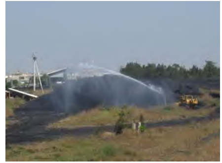
自動灑水設備
