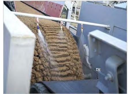
於接駁點設置自動灑水設施
