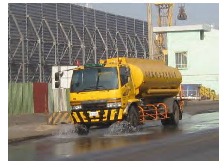
於作業期間灑水，保持路面濕潤
