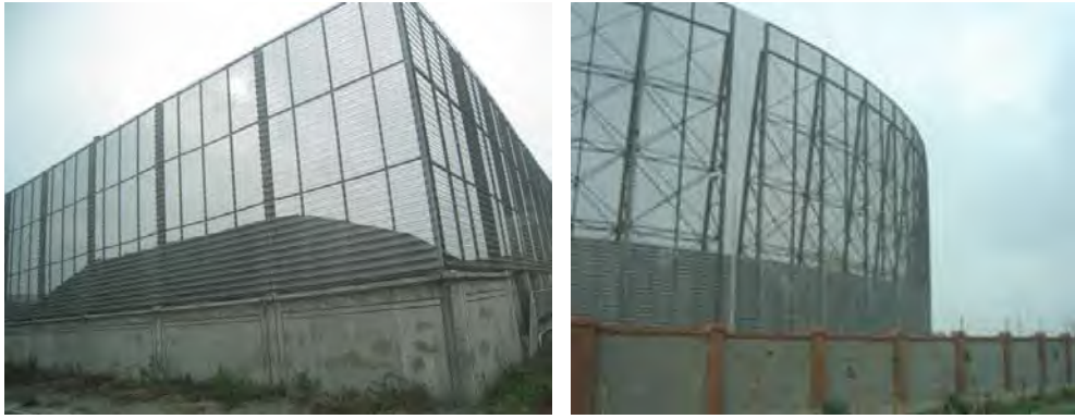
圖3-2 設置混凝土擋風牆實照
