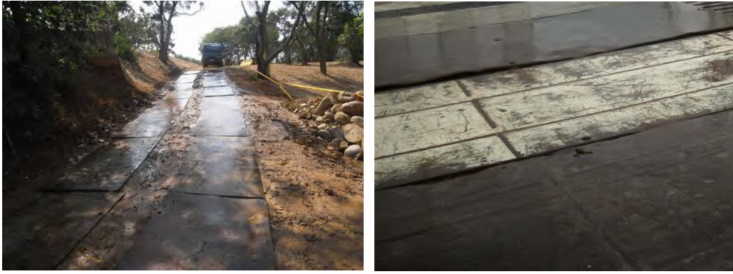
圖3-7 鋪設鋼板實照
