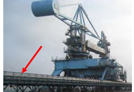
輸送帶兩旁加裝阻隔設施
