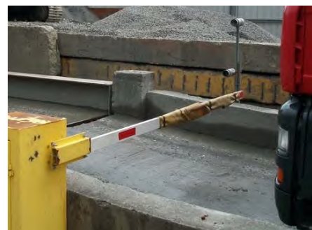
於自動洗車設備出口裝設閘門
