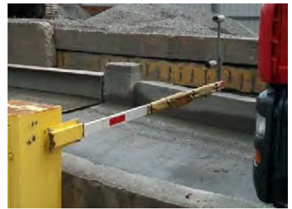
於自動洗車設備出口裝設閘門
