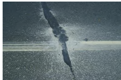
b) 横向裂缝位置唧浆
