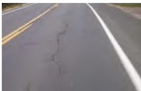
b) 轻度纵向裂缝
