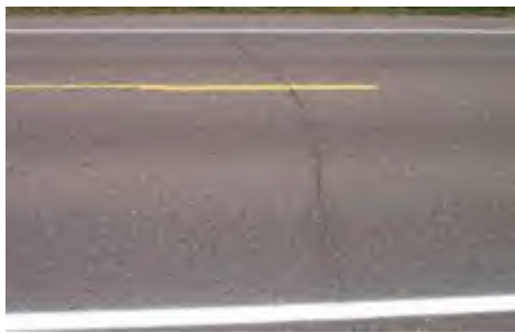
b) 轻度横向裂缝
