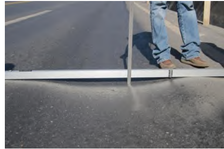
b) 横向裂缝位置唧浆
