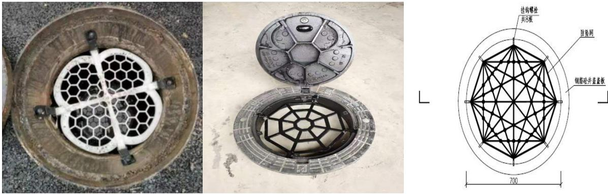
图 2.13 防坠落装置示意图
