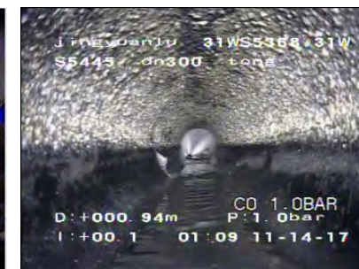
管道腐蚀
