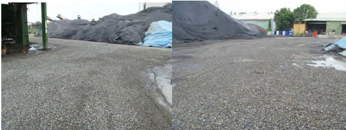
圖3-15 鋪設粗級配實照
