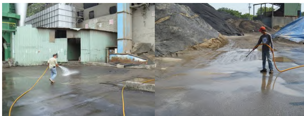
圖3-8 採行人工灑水實照
