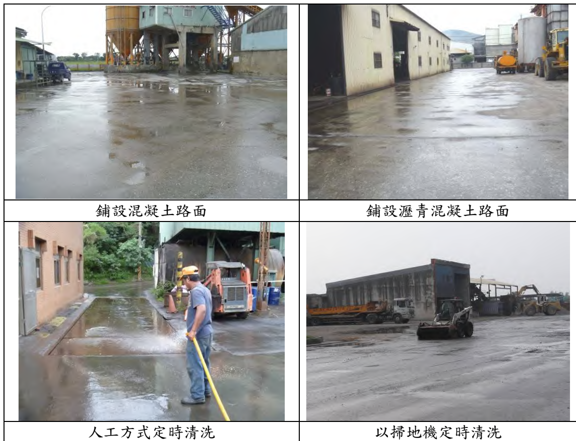
圖3-16 鋪設混凝土及瀝青混凝土實照
