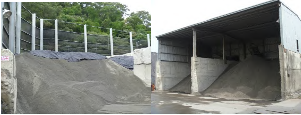
圖3-2 設置混凝土擋風牆實照
