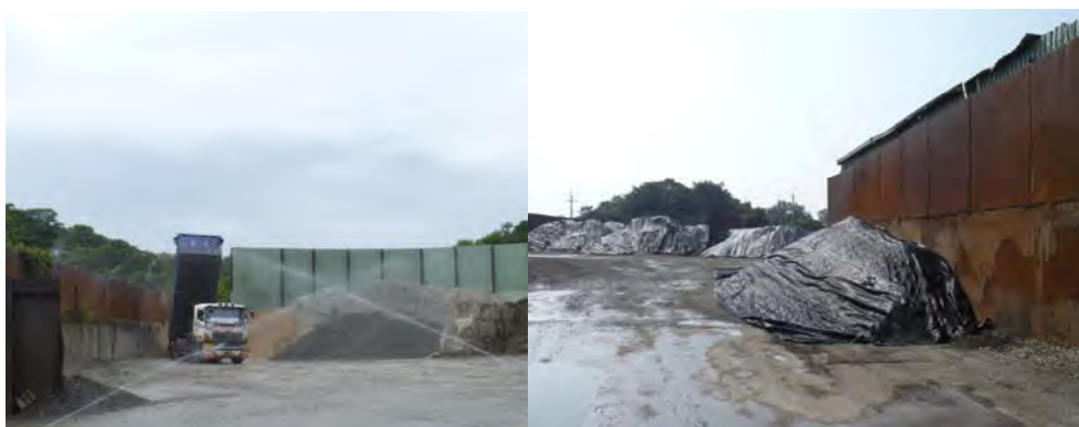
圖3-3 設置鐵皮擋風屏實照
