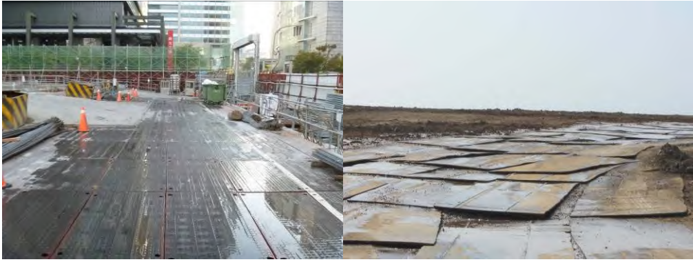
圖3-7 鋪設鋼板實照
