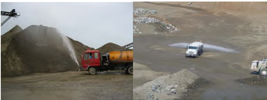
圖3-11 採行灑水車灑水實照
