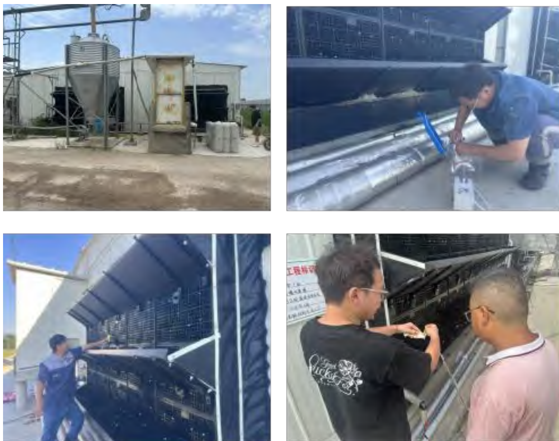
图 5.6-5 现场监测照片
