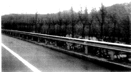
图 7-2 填方路基边坡一级平台栽植乔木绿化效果
