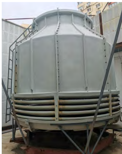
(a) 圆形逆流式冷却塔
