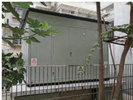
(b) 变压器隔声罩
