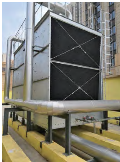
(b) 方形横流式冷却塔
