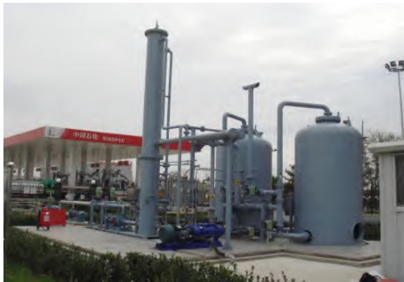
图 18 典型储油库油气回收系统
